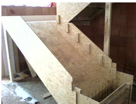
Obr. 6.7 Příklad bednění schodiště
