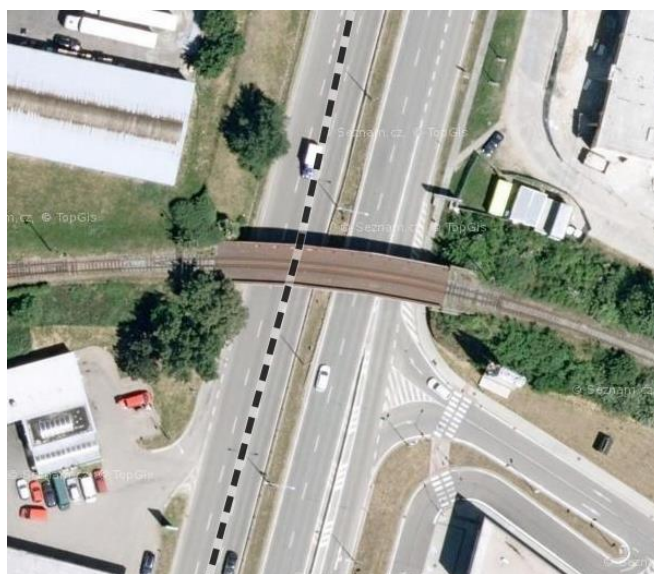
Obr. 3.3 Podjezd pod železničním mostem nad ulicí Heršpická
