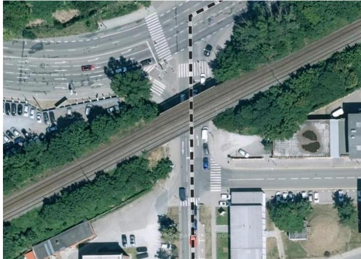
Obr. 3.6 Podjezd pod železničním mostem nad ulicí Masná
