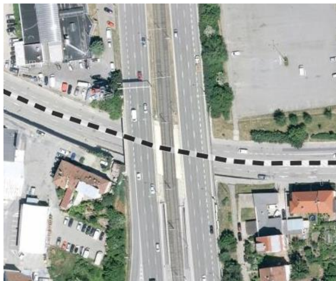
Obr. 3.4 Podjezd pod silničním mostem nad ulicí Bohunická
