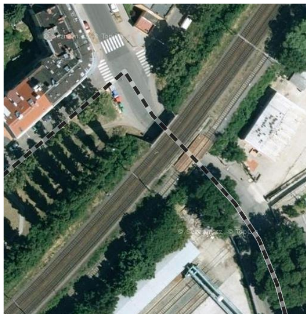
Obr. 3.7 Podjezd pod železničním mostem nad ulicí Šamalova
