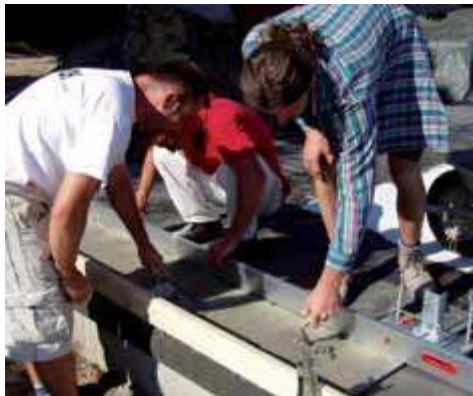
Obr.3 Stažení malty do vodicích lišt pomocí latě
