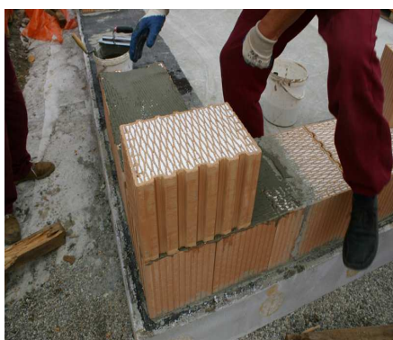
Obr.6 Vazba rohu 2. vrstva
