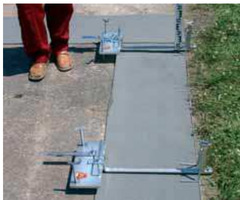
Obr.1 Zaměření základové desky
