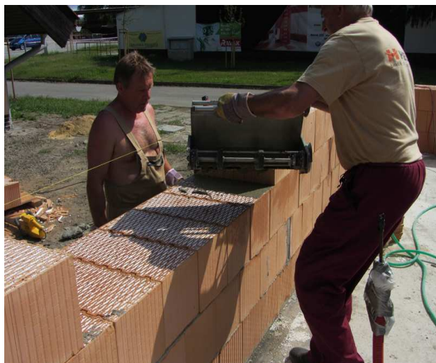
Obr.5 Zdění do šňůrky
