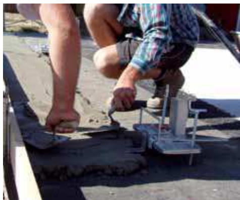
Obr.2 Souvislá vrstva zakládací malty tl. >10mm
