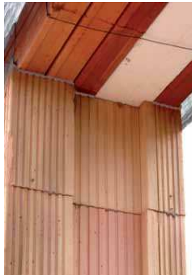
Obr.10 Vyplnění drážky nařezaným EPS.
