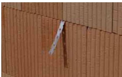
Obr.8 Kotva pro nosné vnitřní zdivo
