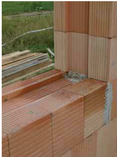
Obr.9 Drážka v ostění a parapetu
