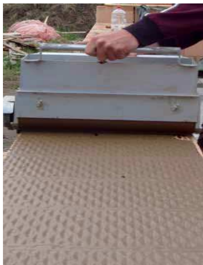
Obr.4 Nanášení celoploš. lepidla pomocí nanášecího válce
