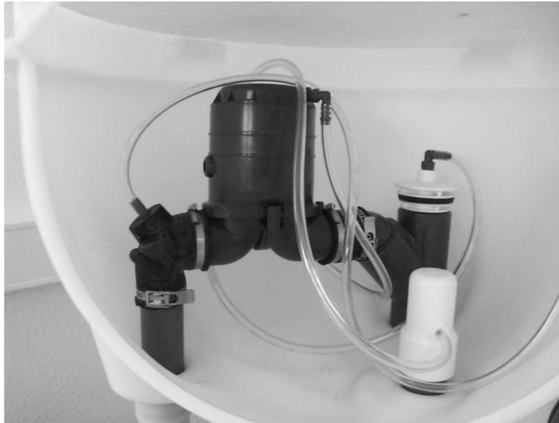
Obr. 8: Sací ventil systému ROAVAC [zdroj: Roediger Vacuum GmbH]
