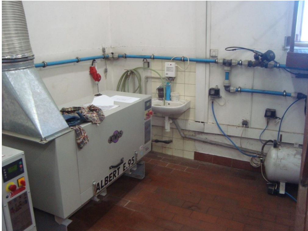
Obr. 16: Kompresory ATMOS SE 80 [zdroj: Lazur]
