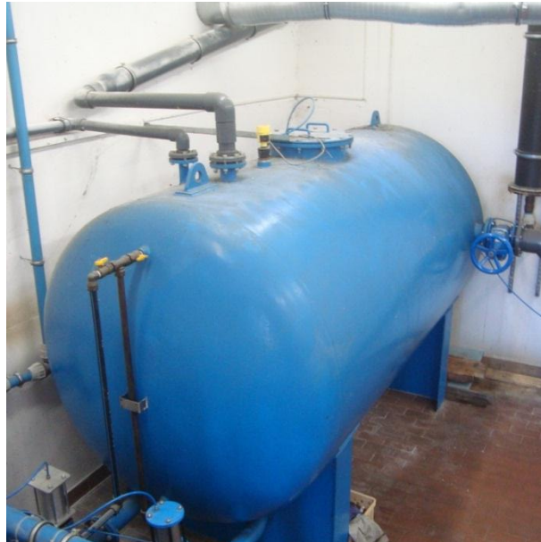
Obr. 20: Podtlaková nádoba [zdroj: Lazur]
