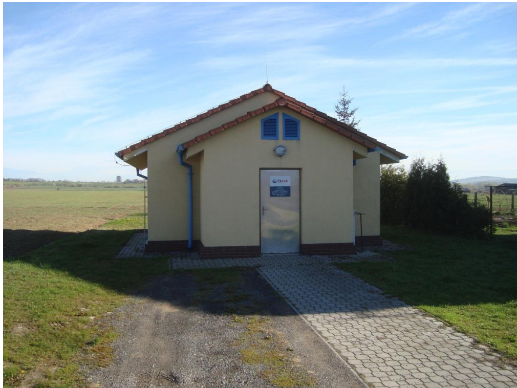
Obr. 14: Podtlaková a čerpací stanice v obci Lužany [zdroj: Lazur]
