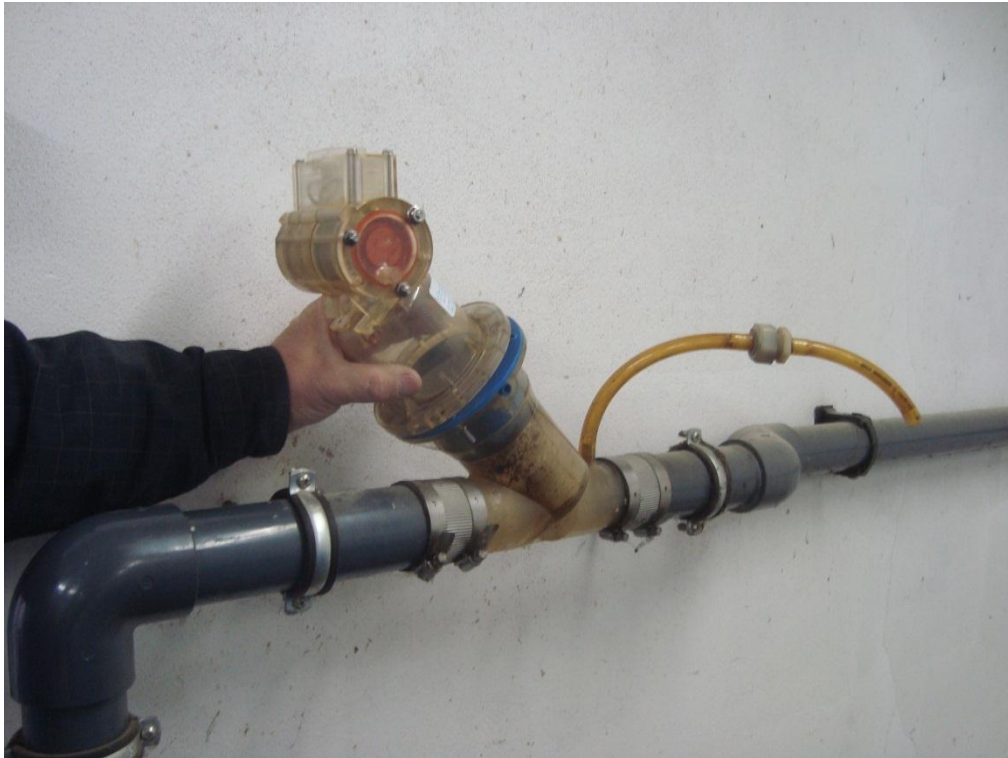
Obr. 18: Sací ventil AIRVAC 2“ - kontrolní ventil [zdroj: Lazur]
