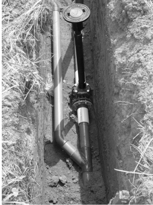
Obr. 10: Ukázka podtlakového potrubí - napojení přípojky do sběrného řadu s uzavírací armaturou [zdroj: Hejna]
