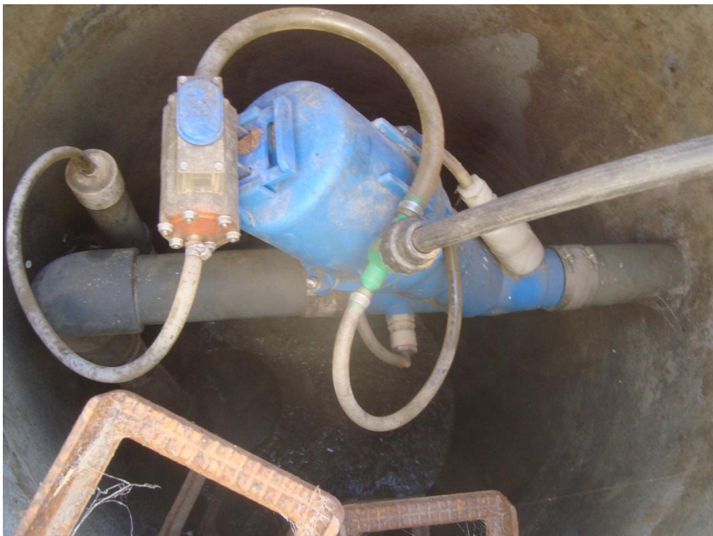
Obr. 19: Sací ventil AIRVAC 3“ ve sběrné jímce pro bytový dům [zdroj: Lazur]
