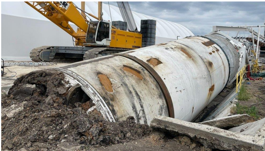
Obr. 12 TBM Prufrock – zahájení těžby [26]
