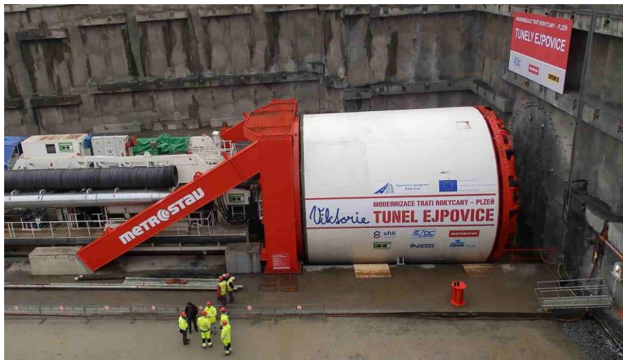
Obr. 10 TBM Viktorie použitá při stavbě železničního tunelu v Ejpovicích [22]
