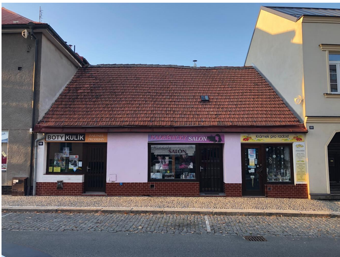
Obrázek 4: Současný objekt určený k demolici
