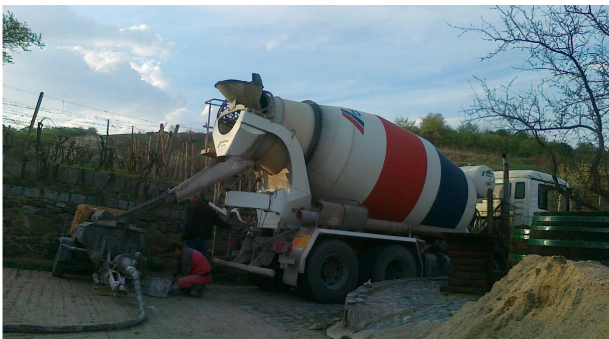
Obr. 12 Přečerpávání pěnobetonu z autodomíchávače na místo pokládky
