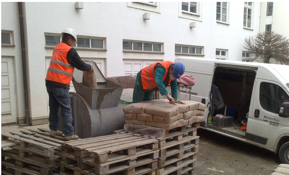
Obr. 9 Ruční dávkování cementu do výrobního zařízení Sircontec MS 1000
