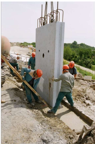
Obrázek č. 14 Osazování prefabrikované stěny [7]
