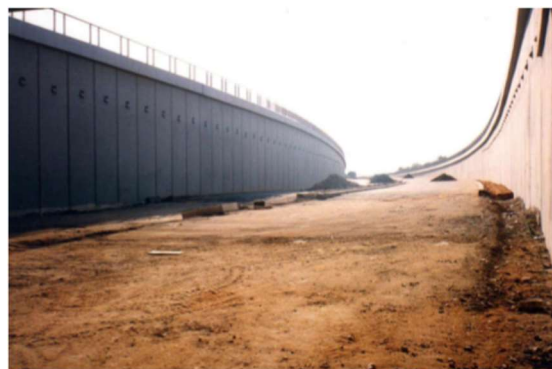
Obrázek č. 13 Pohled na odkrytou prefabrikovanou stěnu [7]
