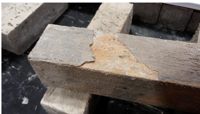
Obrázek 23: Poskození zkušebníko tělesa, opatřeného nátěrem Xypex Concentrate
