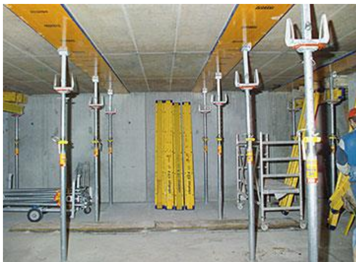
Obrázek č. 6 Pomocné podepření po odbednění
