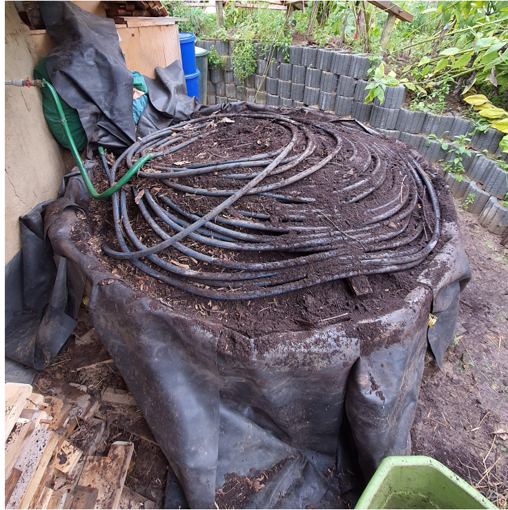
Obr. 5.2: Nálezový stav výměníku původního bioreaktoru
