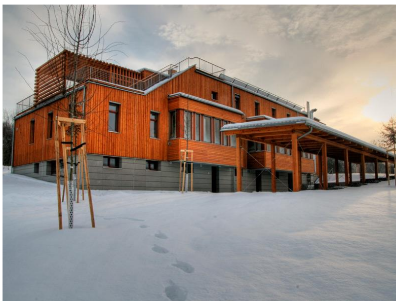
Obr. 1-1 Budova Centra ekologické výchovy Kladno [7]
