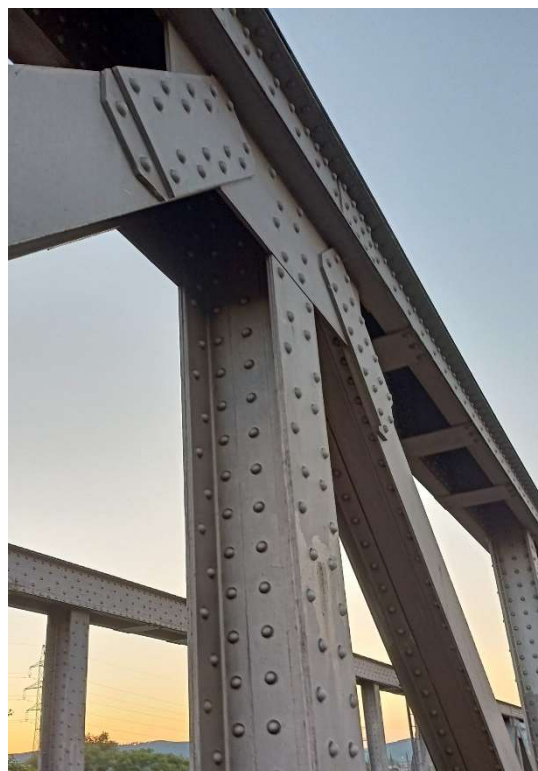
Obrázok 4: Detail nitovaných spojov na moste
