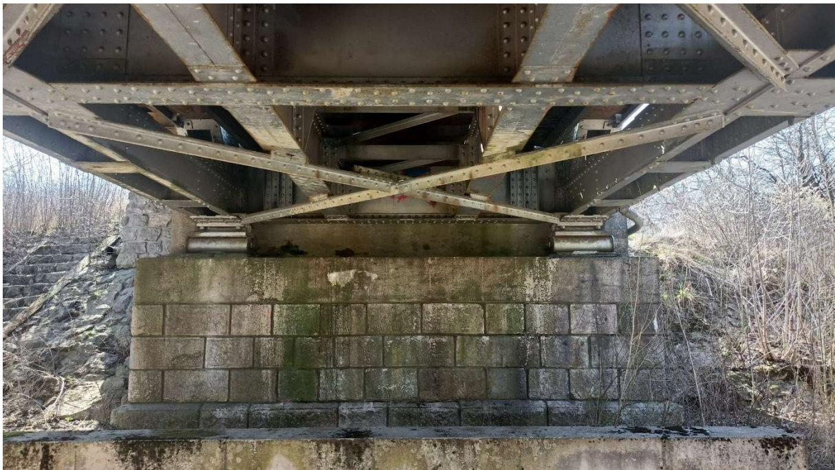
Obrázok 2: Opora a uloženie stávajúceho mostu
