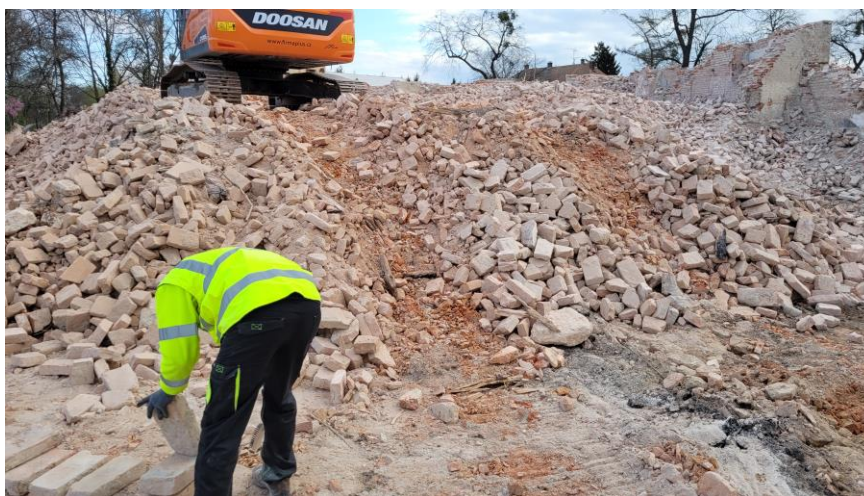
Obr. 34. Čištění a odběr vzorků pro výzkumné práce během demolice Vránova mlýna.
