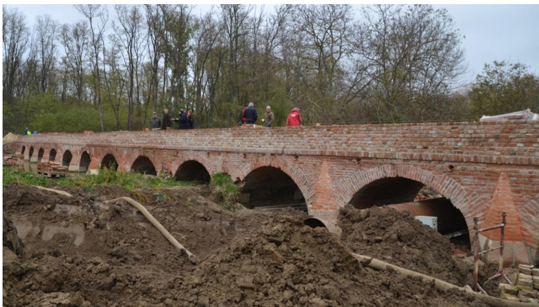
Obr. 30. Cihelný most v Sedleci během rekonstrukce – celkový pohled na most během rekonstrukce.
