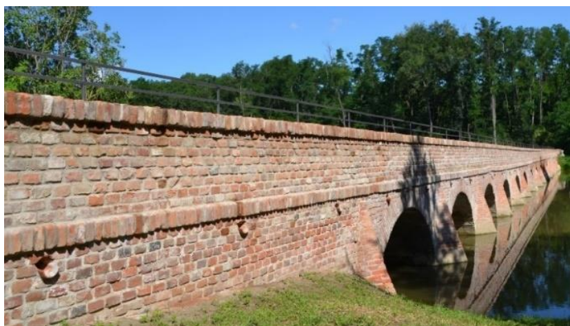
Obr. 2. Barokní cihelný most v obci Sedlec u Mikulova (ČR) po rekonstrukci historickými cihlami [7].
