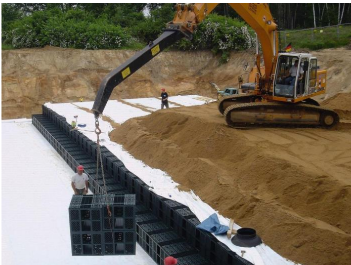
Obrázek 14 výstavba vsakovacího objektu z plastových košů [14]
