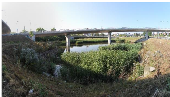
Obrázek 6 Retenční nádrž Královo Pole [vlastní]
