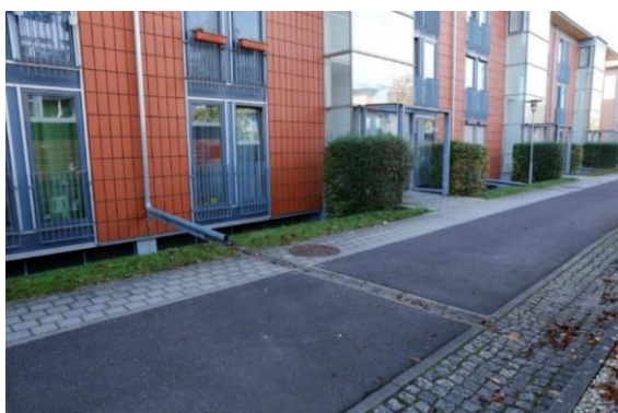
Obrázek 41 Odtok vody ze střech do průleहů [12]
