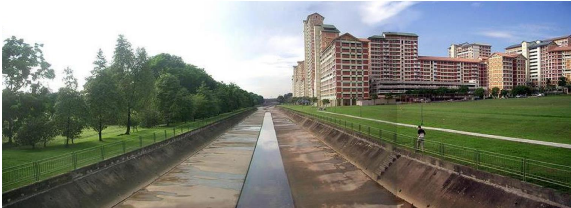
Obrázek 46 Původní stav koryta řeky Kallang [12]
