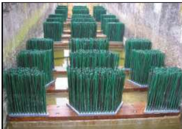
Obrázek 2.21: Kartáčový rybí přechod [14]
