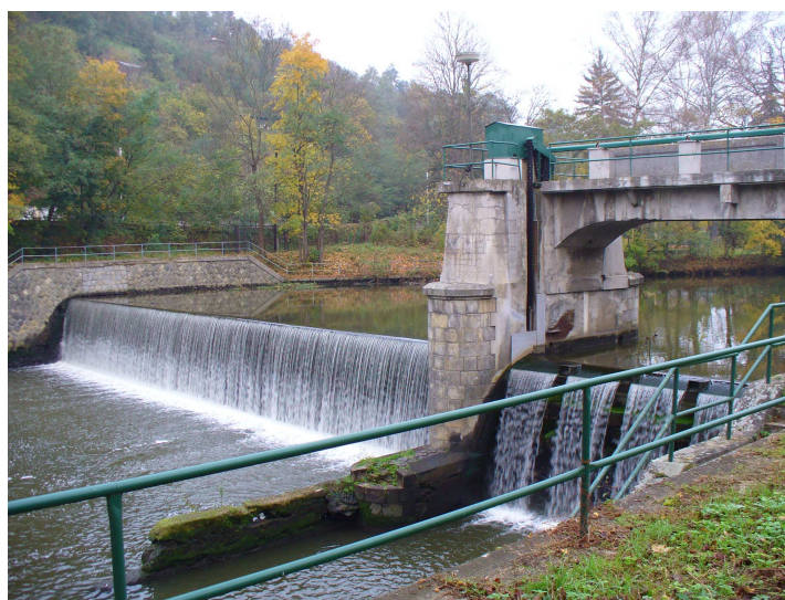
Obrázek 3.8: Současný stav smíšeného jezu Kamenný mlýn (viz P.14)
