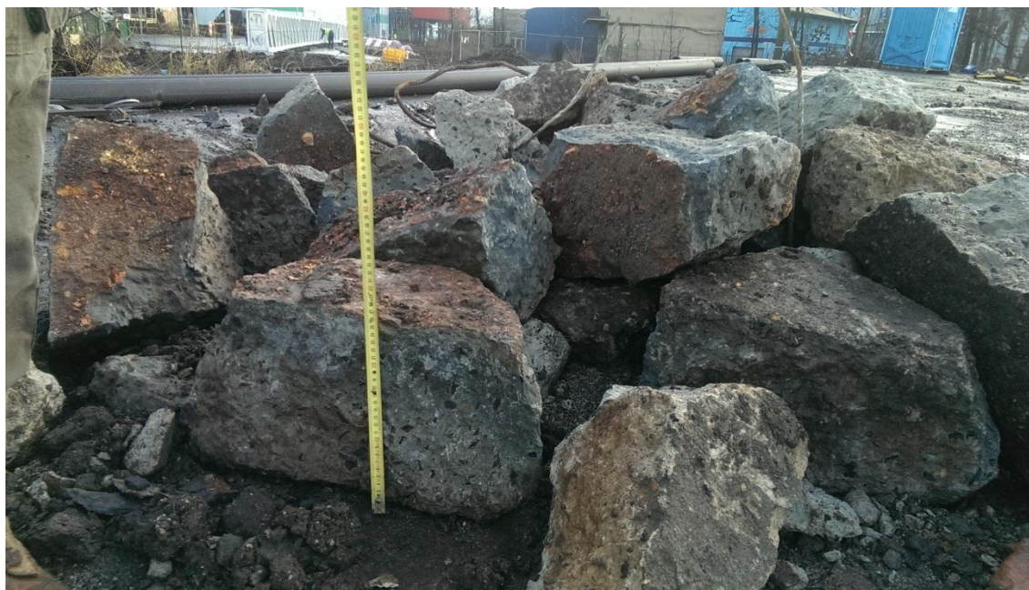
Obr. č. 8: Vrstva betonu v tloušťce 30cm v asfaltové komunikaci [zdroj: vlastní]
