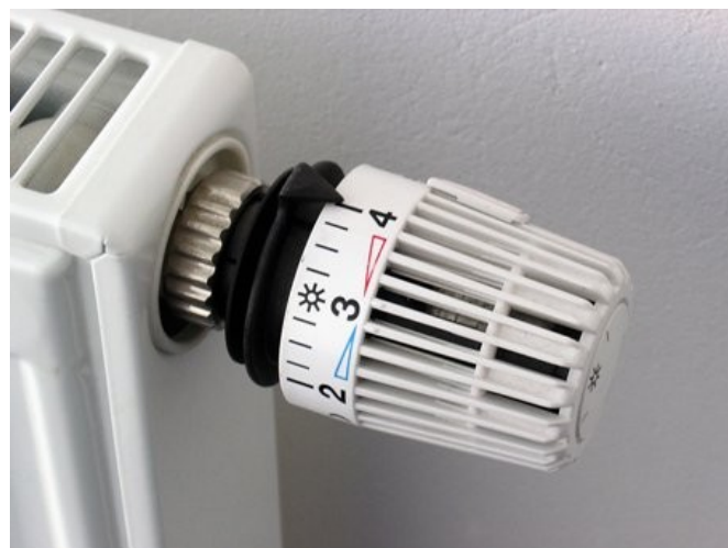
Obr. č. 13 Termostatická hlavice [35]
