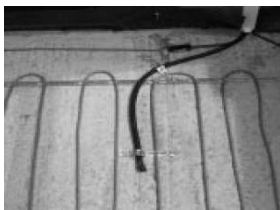
Obr 3-19 Svedení topných kabelů do připojovacích krabic
