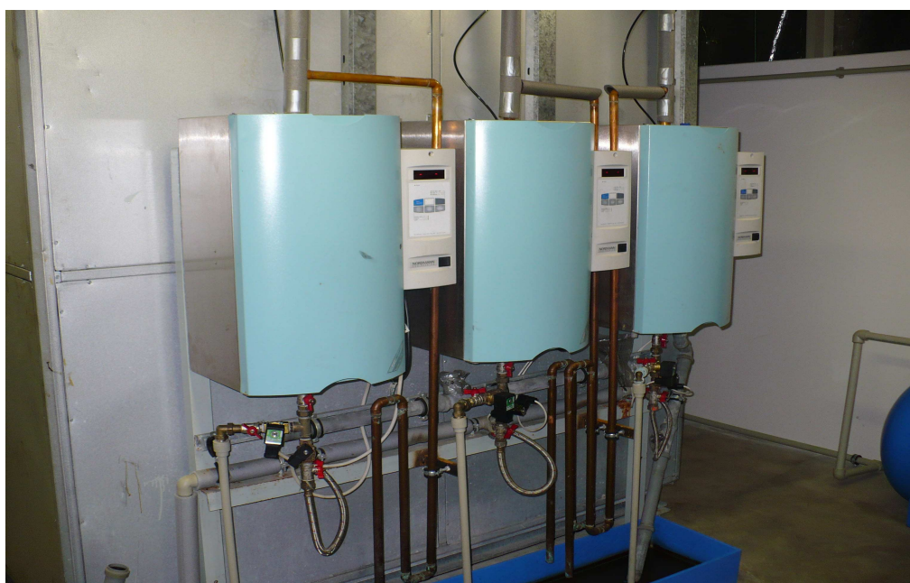
Obr. 3-5 Přídavné zařízení na vlhčení vzduchu, napojeno na VZT pro dílnu WP I
