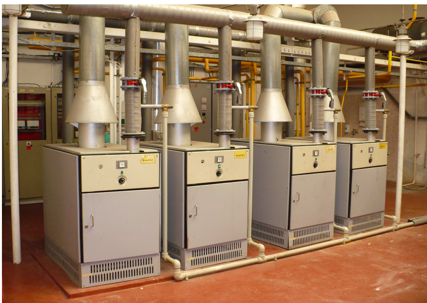
Obr. 4-1 Centrální kotelna s čtyřmi plynovými kotly HOTERM 120 ES
