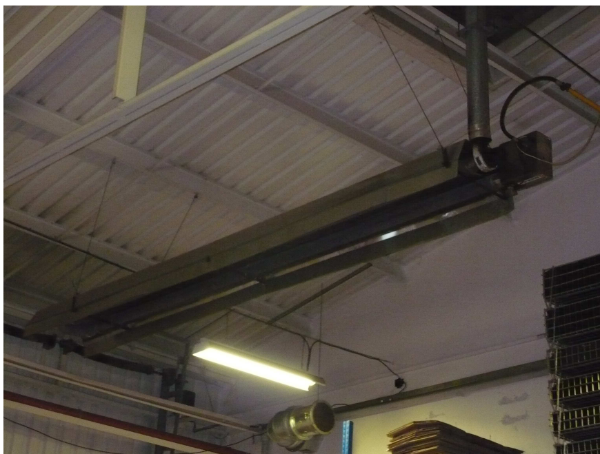
Obr. 3-20 Plynové sálavé topidlo (podstropní zářič) SPACE RAY
