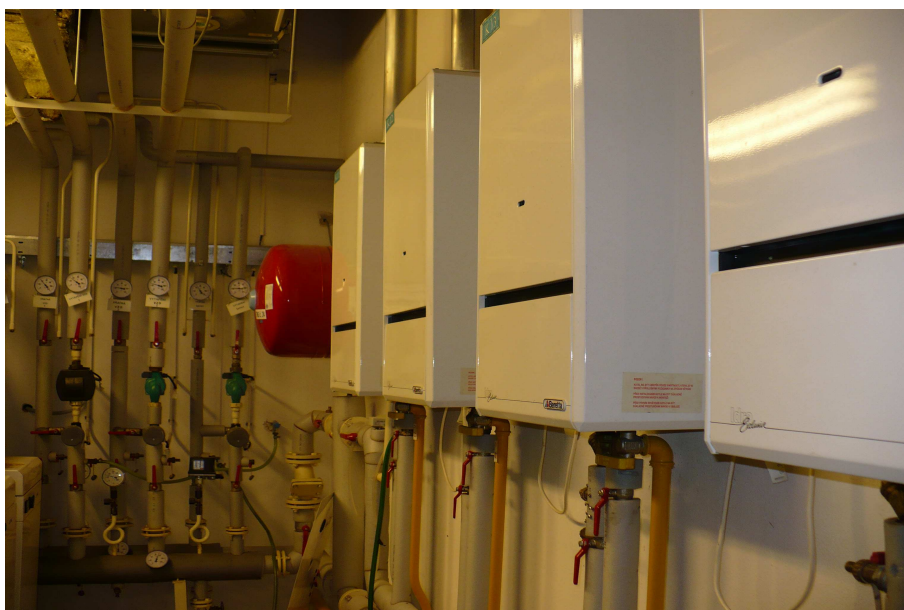
Obr. 3-8 Umístění nástěnných kotlů pro sklad MTZ, dílny údržby, elektro údržby a šaten
