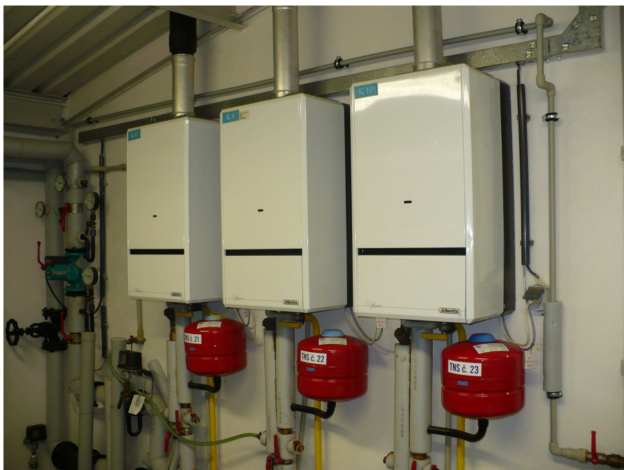
Obr. 3-6 Závěsné plynové teplovodní kotle pro dílnu WP I
