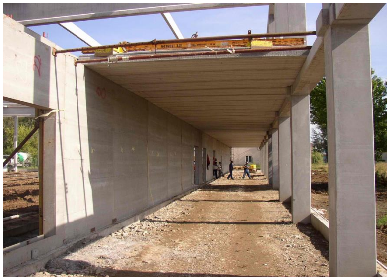
Obr. 51 Osazení panelů SPIROLL na průvlak a dělicí stěnu
