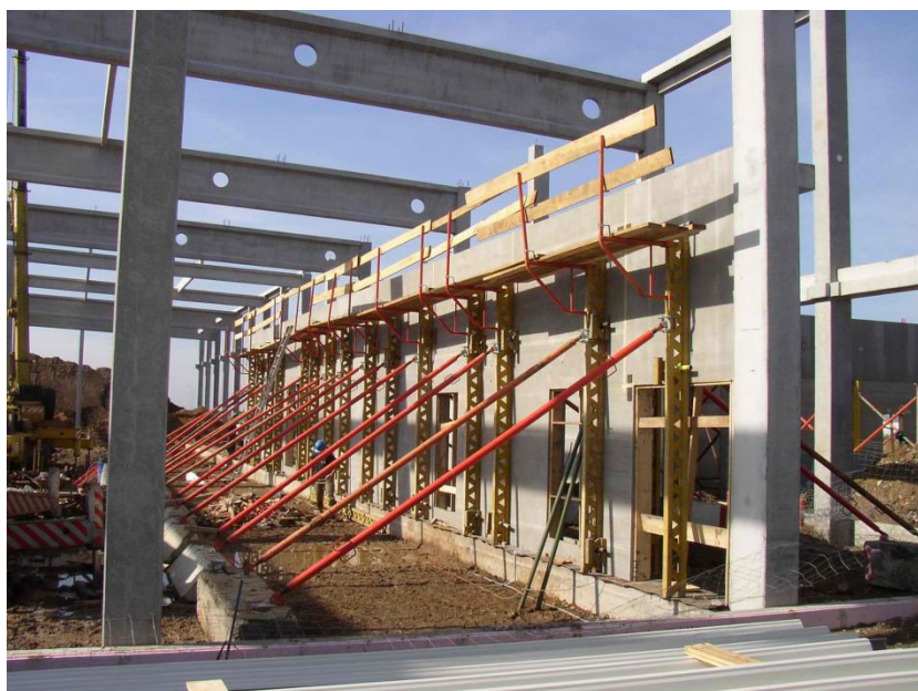
Obr. 49 Stabilizace bednění pomocí nosníků PERI GT 24
