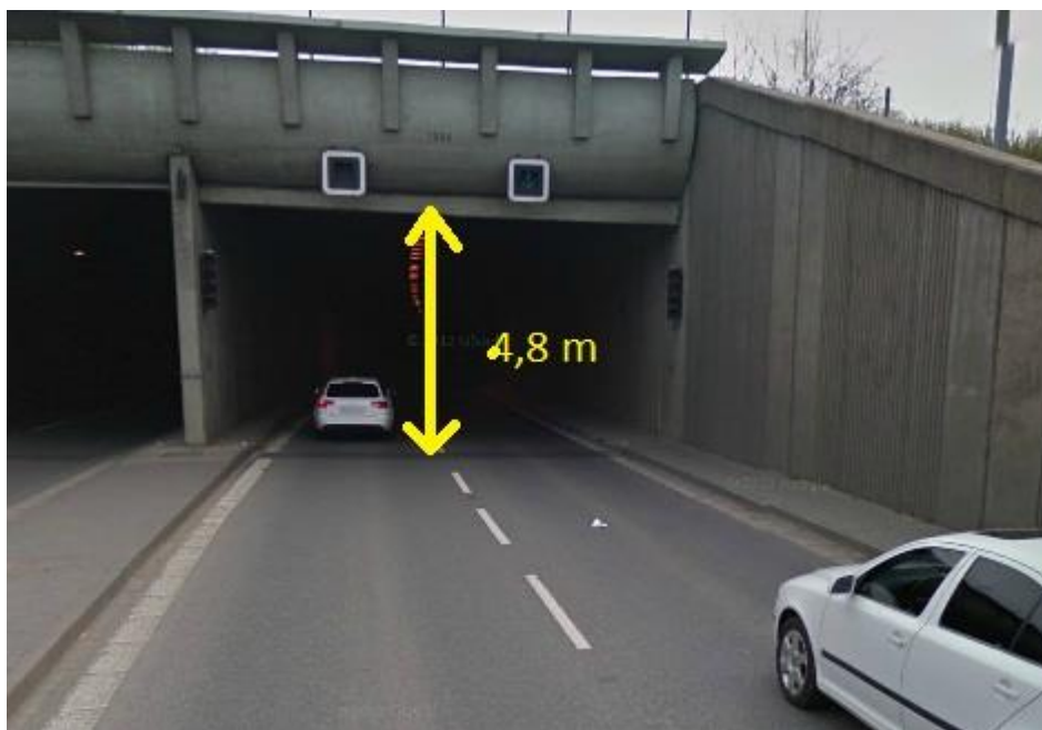
Obr. 12 Výška Husovického tunelu
