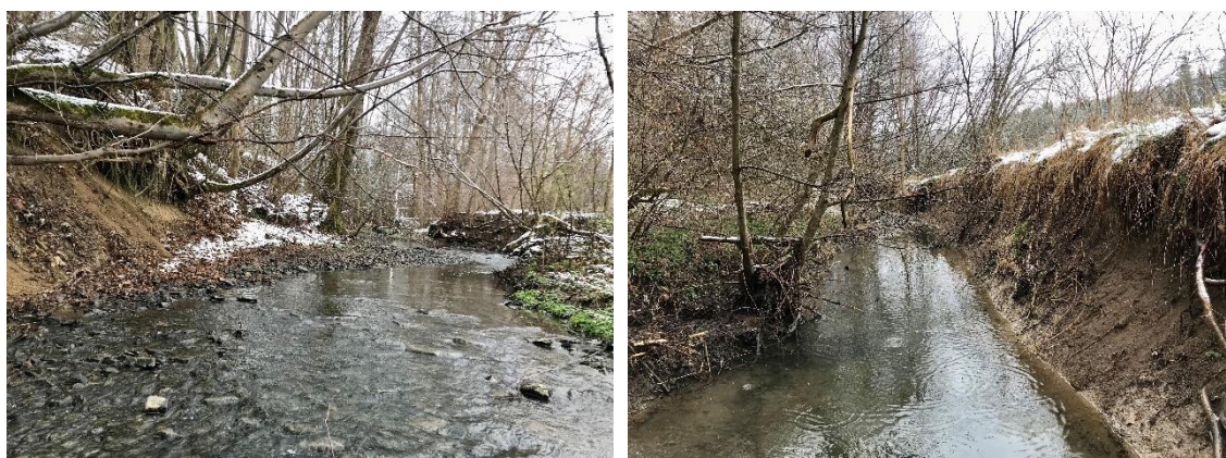
Obr. 6.10 Usazeniny a svahové nátrže (8 a 9)
