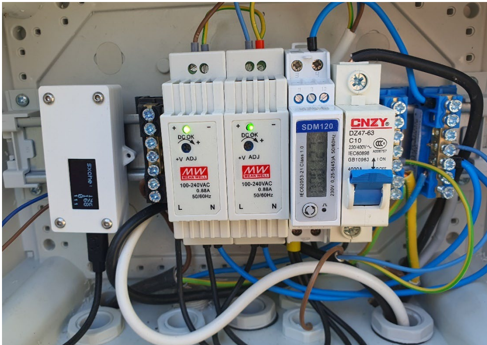
Obrázek 4.29: Zapojení rozvodové skříně
