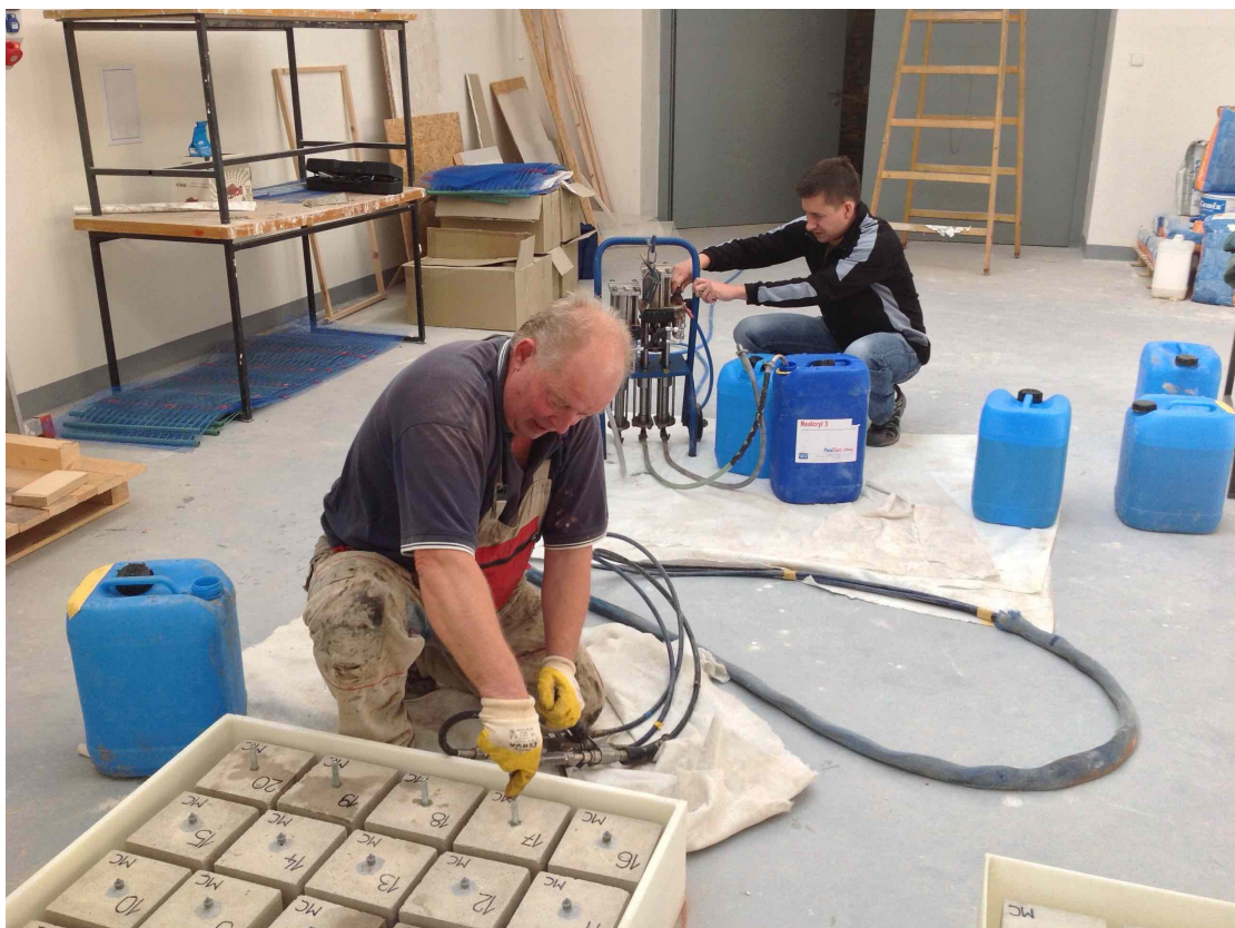
Obr. č. 25 Injektáž chemického přípravku
