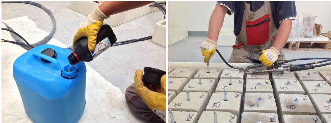
Obr. č. 24 (a, b) Míchání a injektáž chemického přípravku
