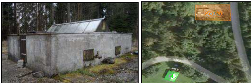
Obrázek č. 8 - Čistírna odpadních vod [vlastní foto] a její poloha v areálu [18]
