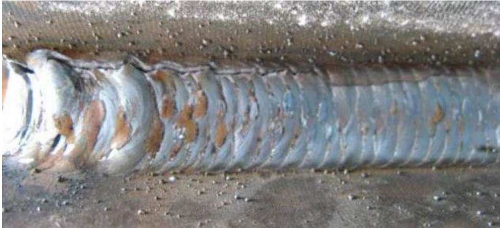
Obr. 20 Svarový spoj s trhlinou za studena [35].
