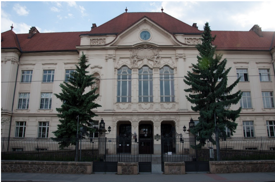
Obr. 3 Aktuálny pohľad na budovu A stavebnej fakulty [autor]
