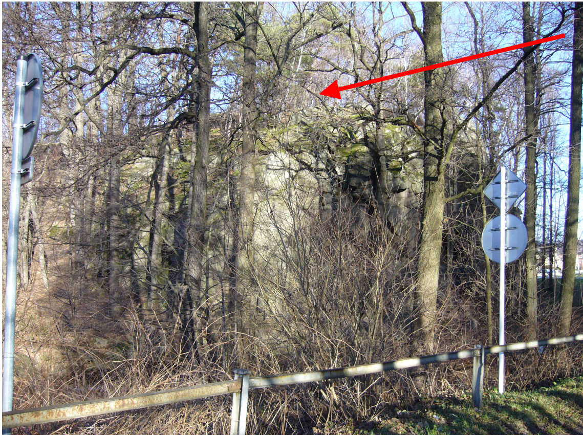
14 – Pohled na S – Překročení údolí přes Stříbrný potok mostem okolo km 3,150
