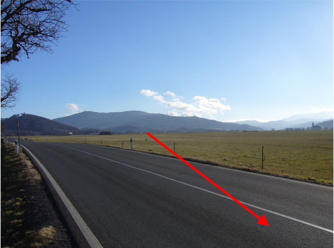
21 – Pohled na JV – Napojení na stávající stav silnice I/60 okolo km 5,550
