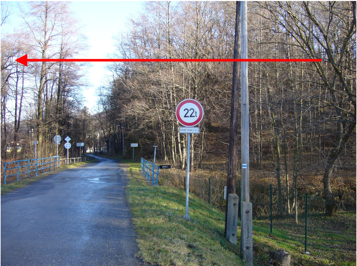
12 – Pohled na SV – Překročení údolí přes Stříbrný potok mostem okolo km 3,130
