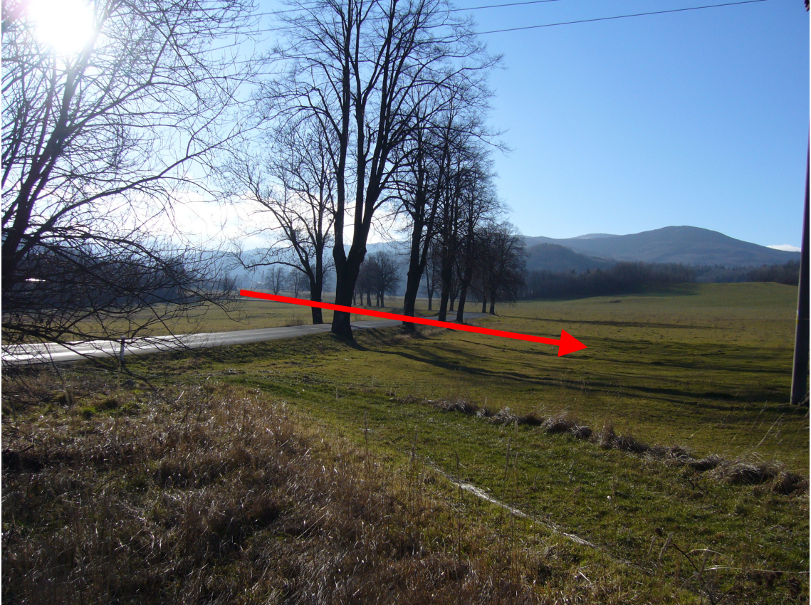
11 – Pohled na J - Stávající stav silnice I/60 okolo km 2,800
