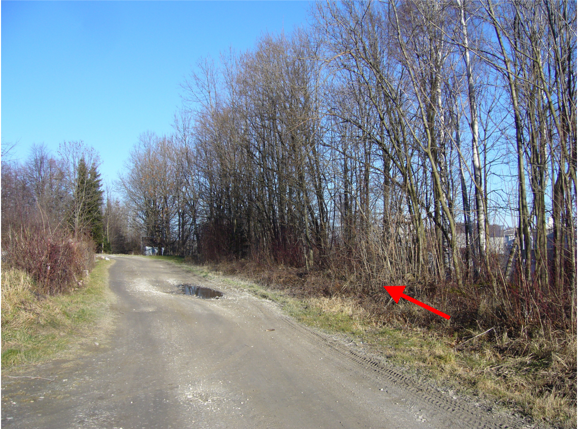
03 – Pohled na S - Rovnoběžná účelová komunikaci okolo km 0,920
