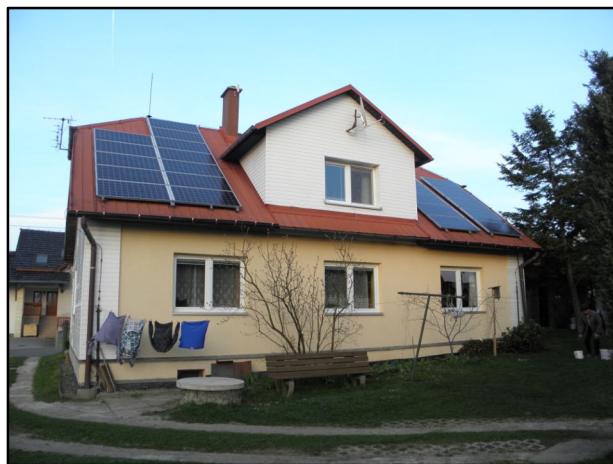
Jižní pohled na RD č. 1
