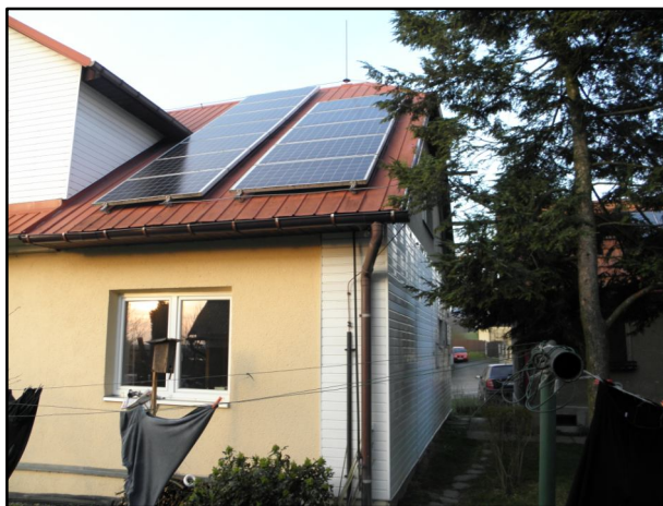
Východní pohled na RD č. 1
