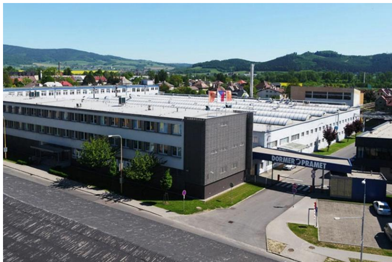
Obr. 4 Šumperská výrobní jednotka Dormer Pramet [10].
