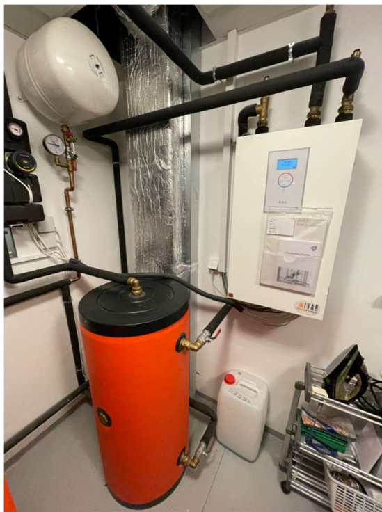
Obrázek 54: Vnitřní jednotka tepelného čerpadla IVAR Thermia ATEC + techn. místnost
