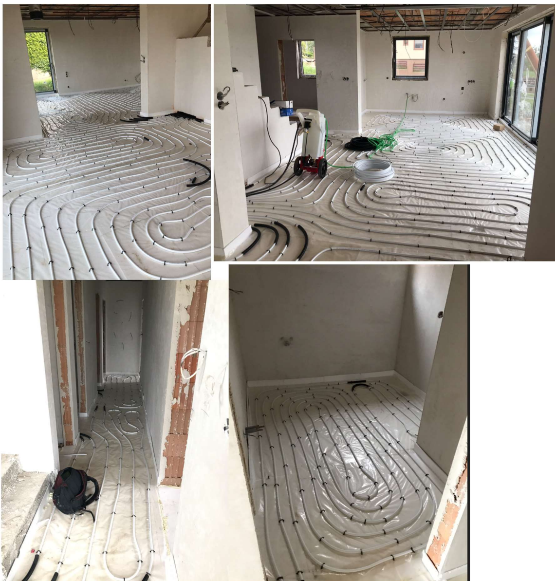
Obrázek 52:Foto z montáže podlahového vytápění
