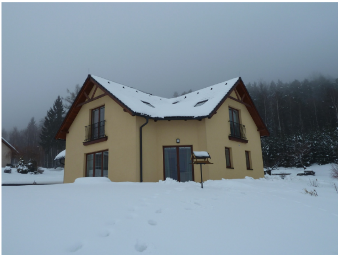
Obr. č. 5-1: Rodinný dům, na kterém došlo dne 5.3.2012 ke škodné události způsobené tíhou sněhu
