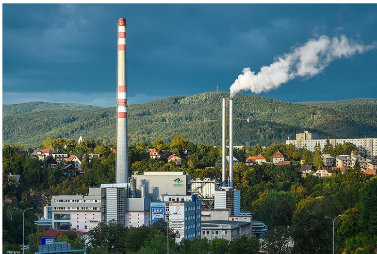
obrázek 3-4 TERMIZO Liberec, a.s [39]
