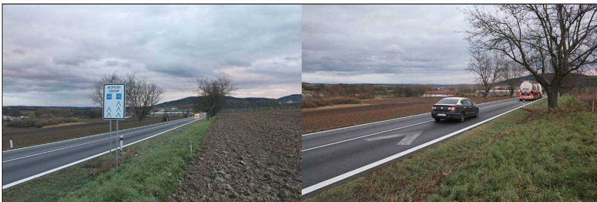
Obrázek 14: Svislé, resp. vodorovné dopravní značení pro dodržování bezpečného odstupu na měřeném úseku
