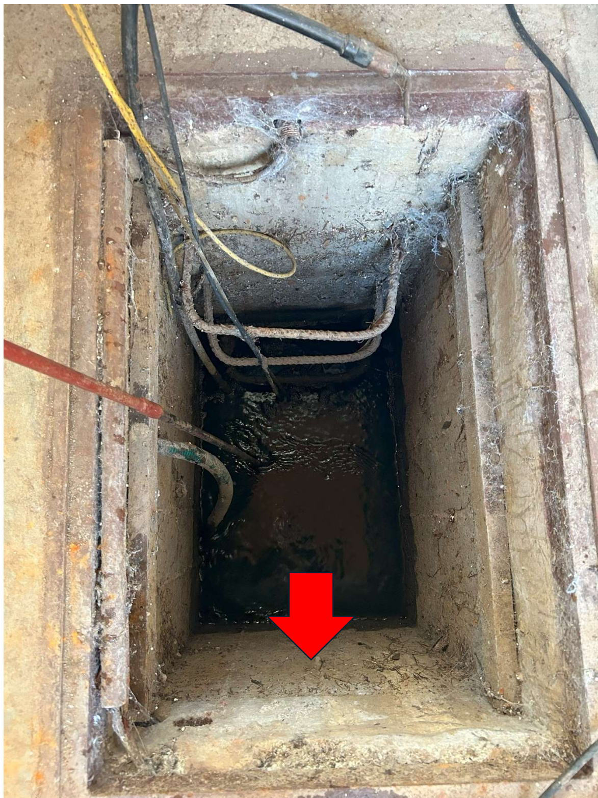
Foto 6 – Pohled do čerpací šachty – předpokládané napojení přívodního potrubí k MVE [4]
