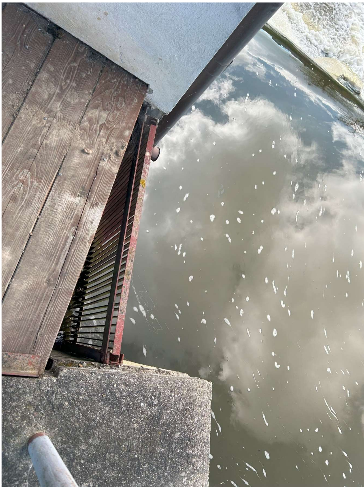
Foto 4 – Předpokládané nahrazení česlí odběrného objektu na levém břehu [4]
