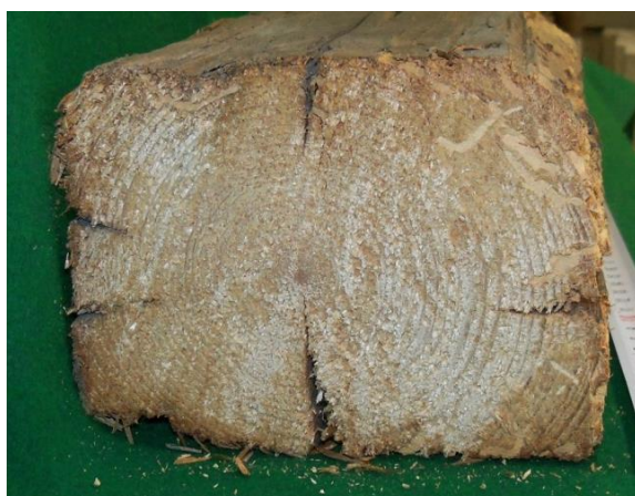
Obr. 26: Pohled na zhlaví na začátku trámu
