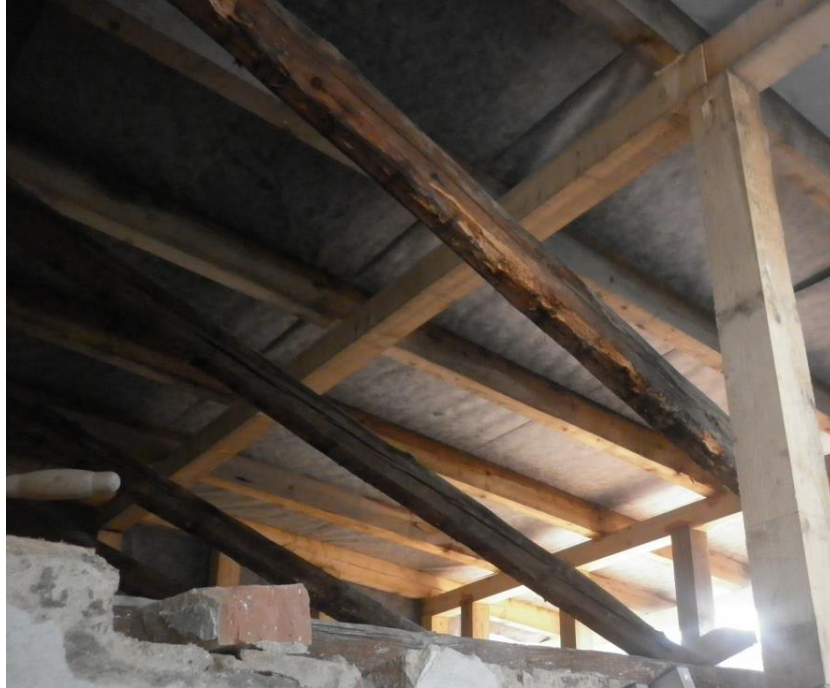
Obr. 23: Pohled na trám v původní konstrukci
