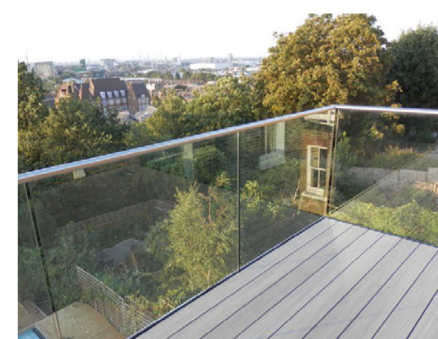
Prosklené zábradlí s nerezovým madlem (10)
