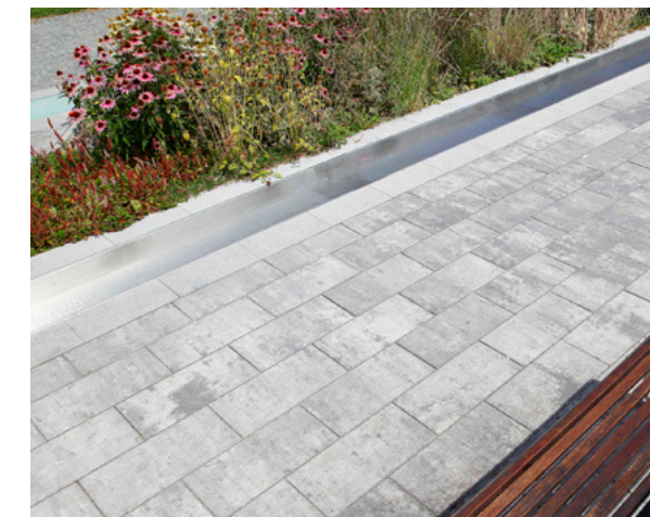
Betonové velkoformátové dlaždice kladeny v opačném směru (3)
