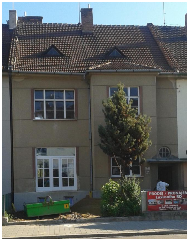
Obr. 4: Dům na počátku rekonstrukce
