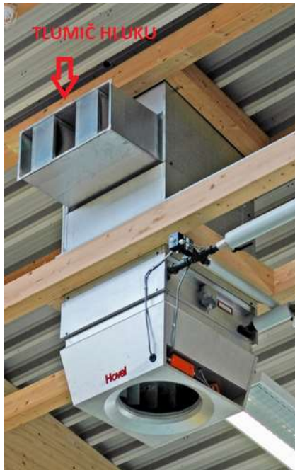
Obrázek A.1.9 Jednotka vybavená tlumiči hluku přiváděného i odváděného vzduchu [50]
