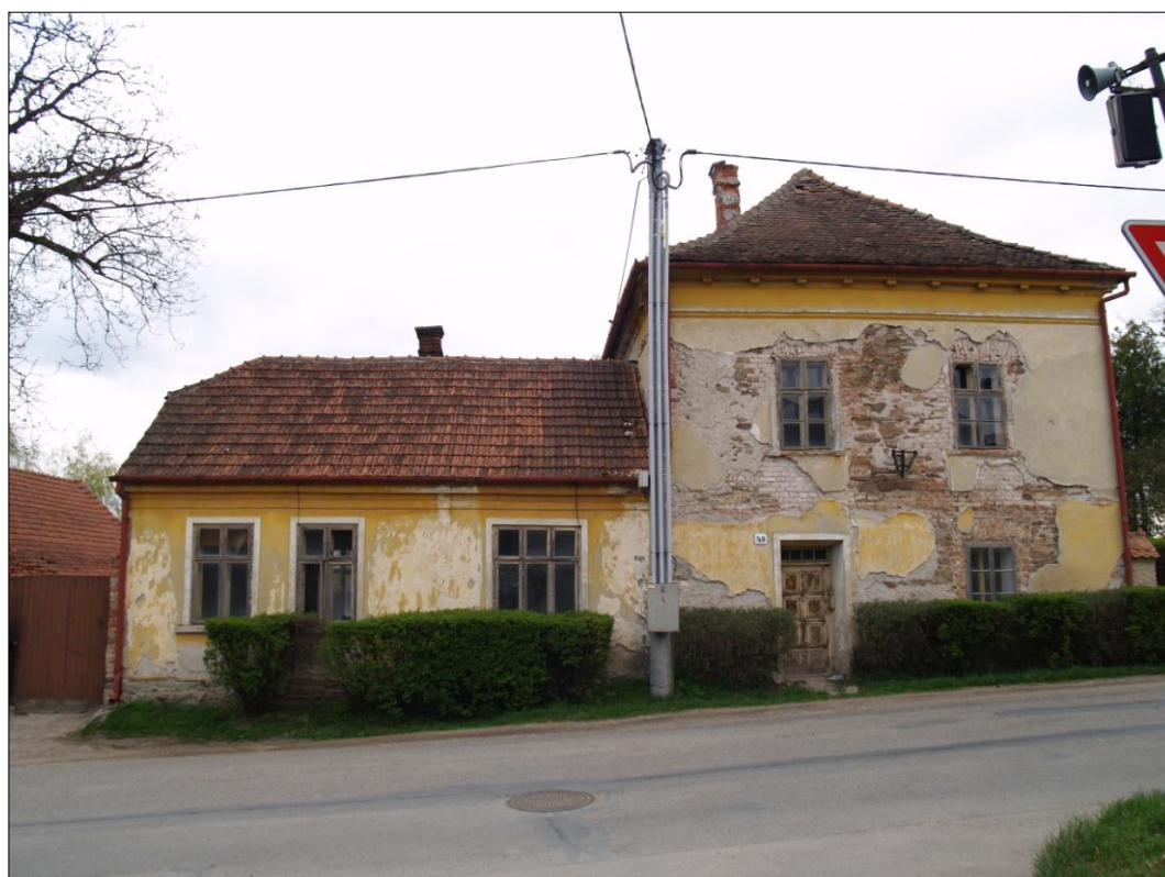
Obr.17 Pohled z ulice (v levé části fotografie je pozdější přístavba)
