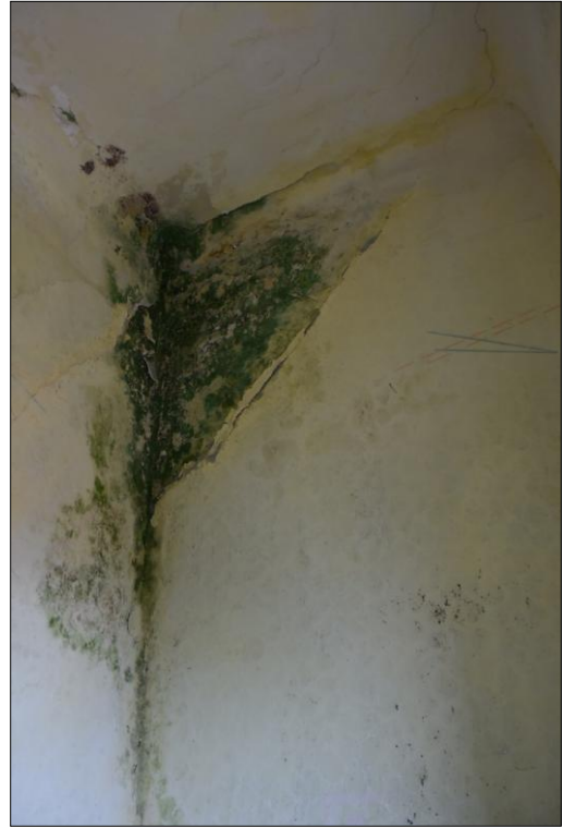
Obr.33,34 Místo T8 porušené průsakem dešťové vody skrze díry ve střeše
