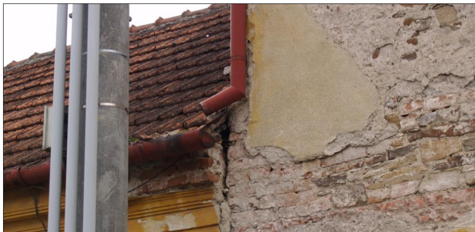
Obr.24 Neprovázané zdivo (důkaz přístavby)
