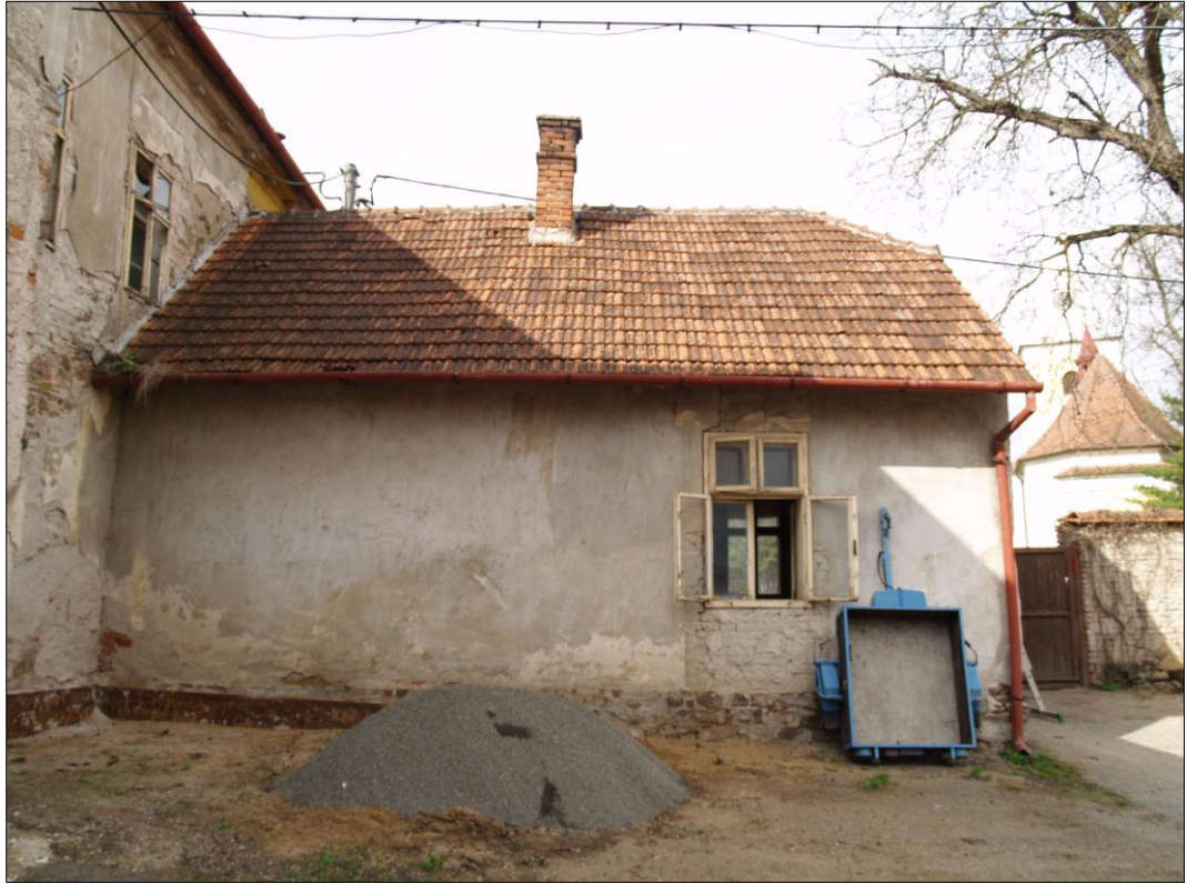
Obr.18 Pohled z pozemku na přístavek
