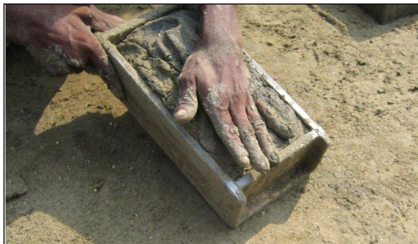
Ruční vkládání suroviny do formy (prstování)[Obr.2]
