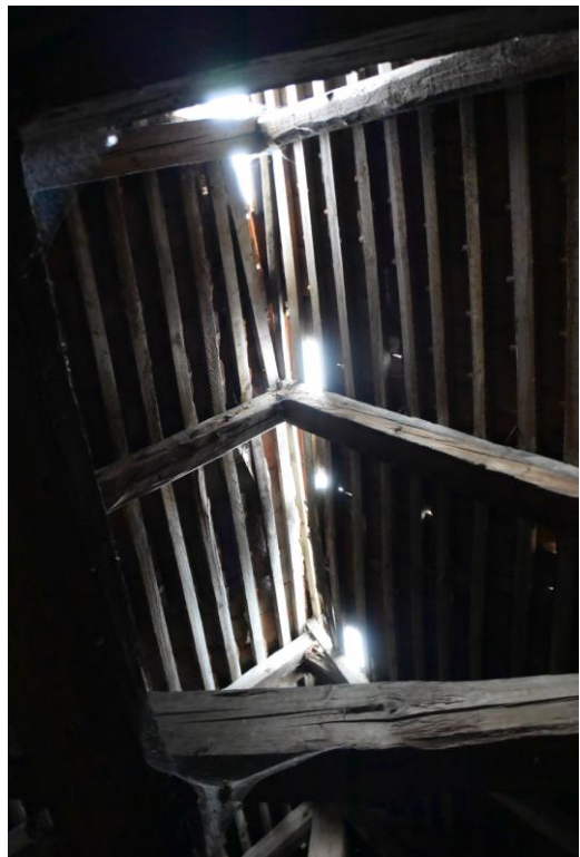
Obr.35,36,37 Lokální poruchy ve střeše-zatékající dešťová voda je příčinou chátrání objektu
