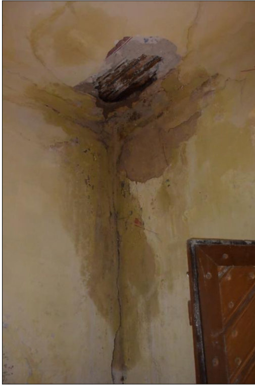
Obr.33,34 Místo T8 porušené průsakem dešťové vody skrze díry ve střeše
