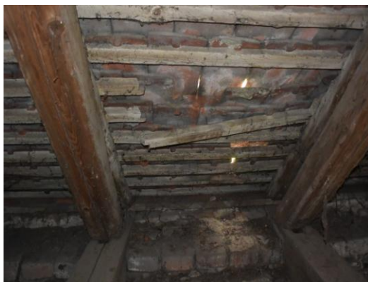
Obr.35,36,37 Lokální poruchy ve střeše-zatékající dešťová voda je příčinou chátrání objektu
