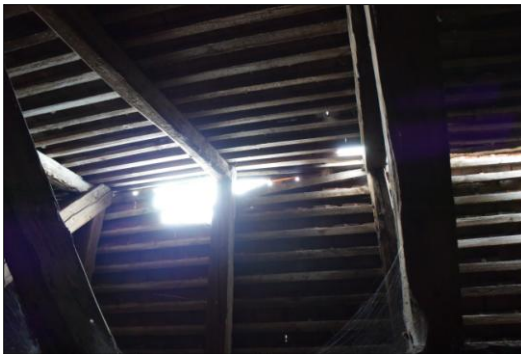
Obr.33,34 Místo T8 porušené průsakem dešťové vody skrze díry ve střeše
