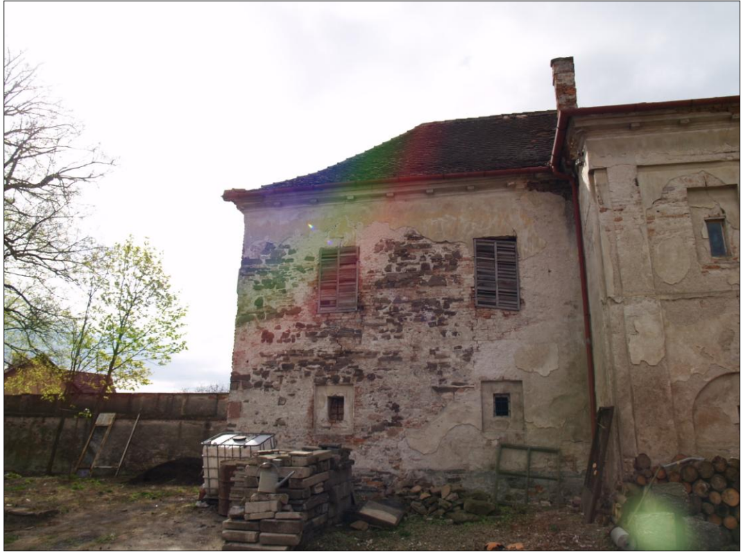
Obr.20 Přistavěná sýpka pro skladování obilí
