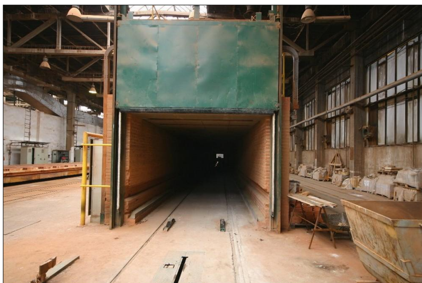
Pohled do tunelové pece [Obr.6]
