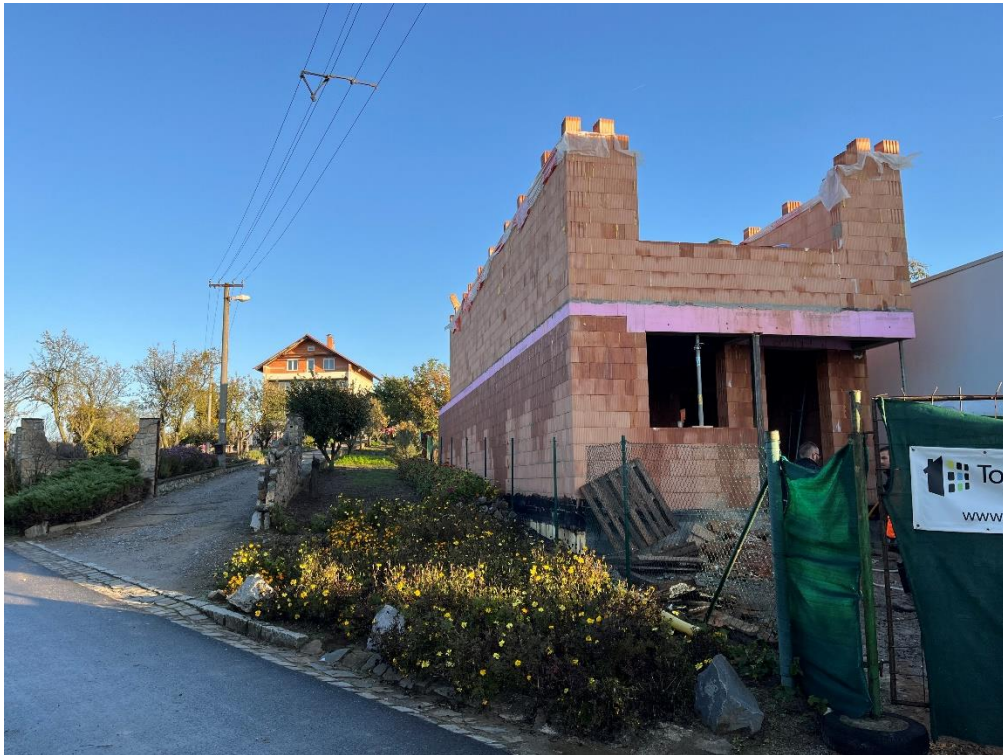
Obrázok 5: Stavba v štádiu rozostavanosti k 15.10.2024 [vlastné spracovanie]
