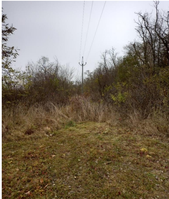
Obrázek 5.6 Trasa vedení a špatně přístupná místa
