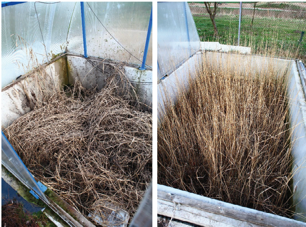
Obrázek 42. Kalové pole osazené rákosem obecným na konci vegetačního období na ČOV Dražovice (vlevo se skleníkovým přístřeškem, vpravo bez přístřešku)
