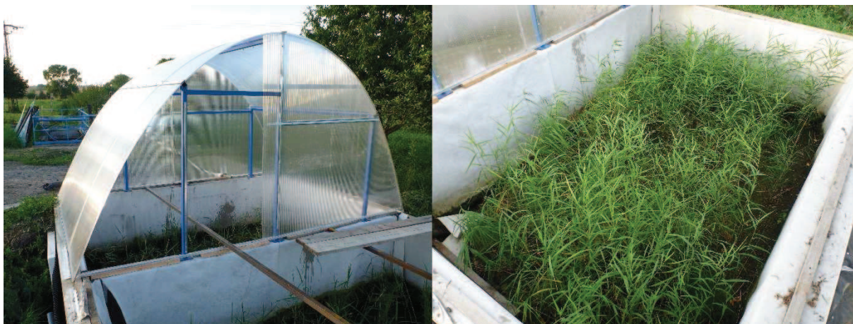
Obrázek 14. Kalová pole v Dražovicích - vlevo se skleníkovým přístřeškem a vpravo bez přístřešku
