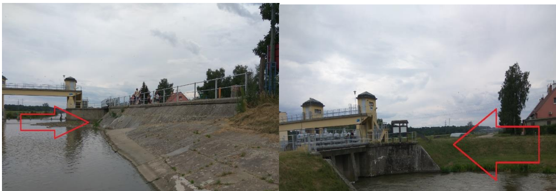
Obr. 8.3: Současný stav nátokový objekt do ramene Staré Moravy
