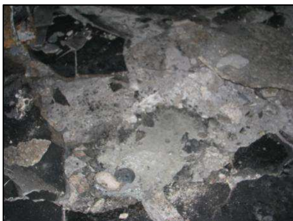
Obr. 1a Pohled na odběrové místo jádrového výtvaru s označením PN.1.01 odebraného ze stropní železobetonové desky nad 1. PP
