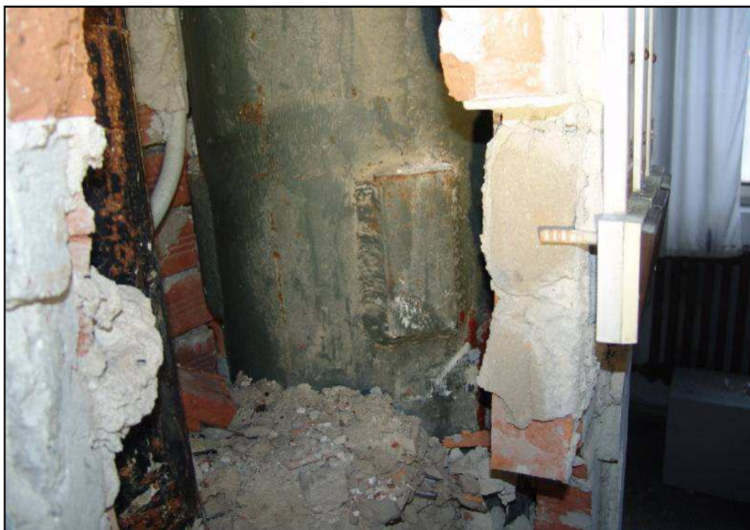
Obr. 2b Sonda S3 – detail ocelového sloupu s deskovým návarkem
