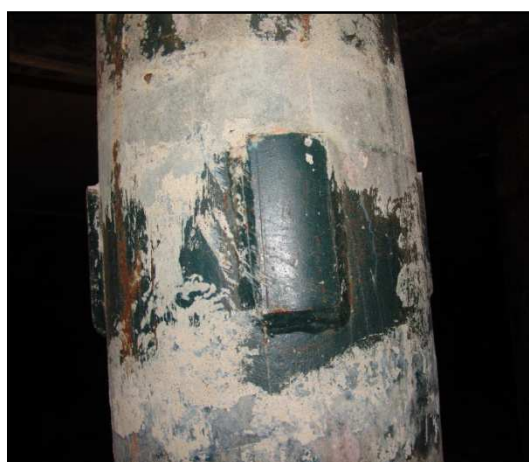
Obr. 1d Sonda S1 – detail ocelového sloupu s návarky
