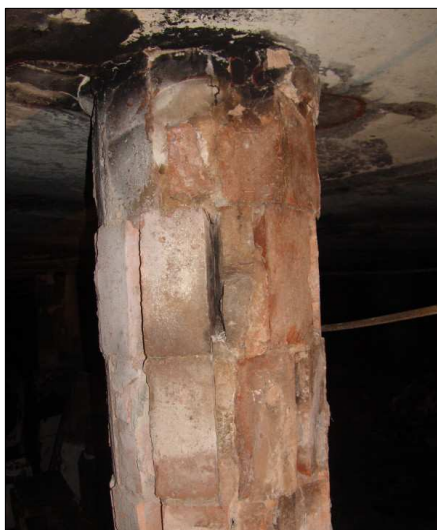
Obr. 1b Sonda S1 – detail obezdívky
