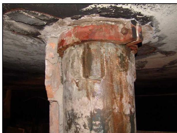
Obr. 1c Sonda S1 – detail ocelolitinové uchycovací objímky
