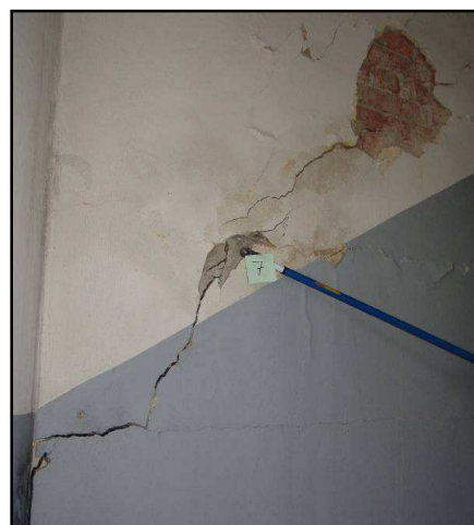
Obr. 2.15 Poškození schodišťového tělesa a přiléhající místnosti v 2. NP objektu C (detail šikmé trhliny ve zdivu svislé stěny)
