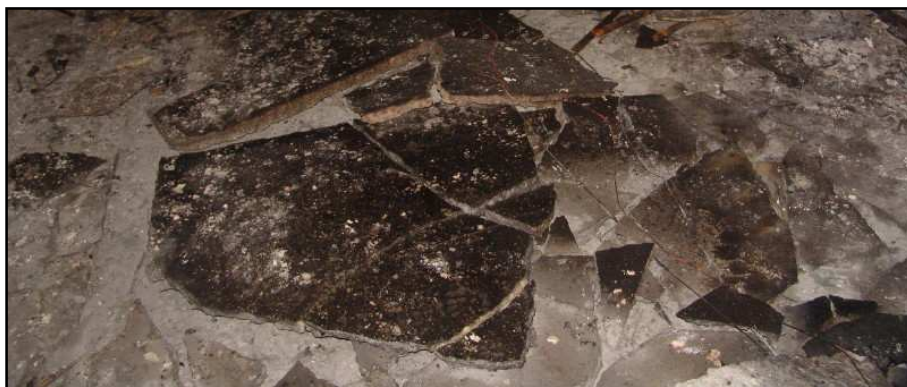
Obr. 1.7 Destrukce podlahových betonových vrstev stropních konstrukcí nad 1. NP části A
