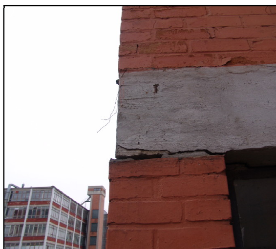
Obr. 2.11 Vybočení obvodového zdiva schodišťového tělesa objektu C
