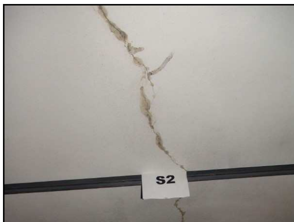
Obr. 1.5 Liniové trhliny dolního líce stropní desky nad 1. PP
