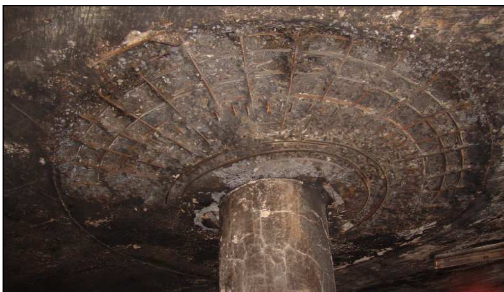
Obr. 1.3 Odštěpování krycích vrstev betonu z hlavic desky nad 1. NP části A
