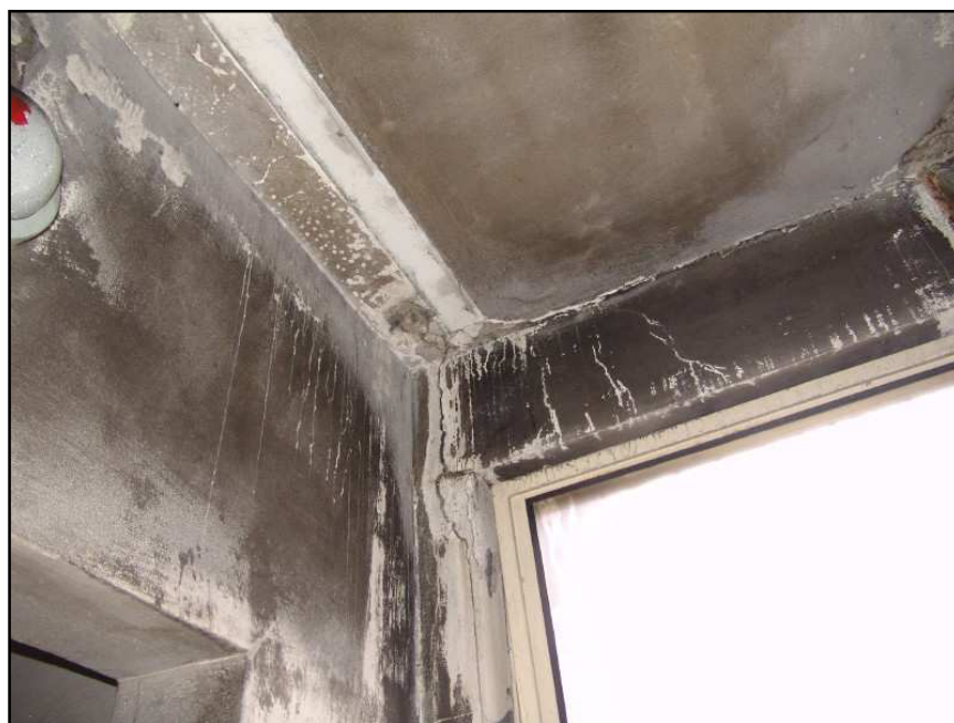
Obr. 1.18 Poruchy na styčích prefabrikovaných dílců obvodového pláště u východní věže v úrovni 2. NP
