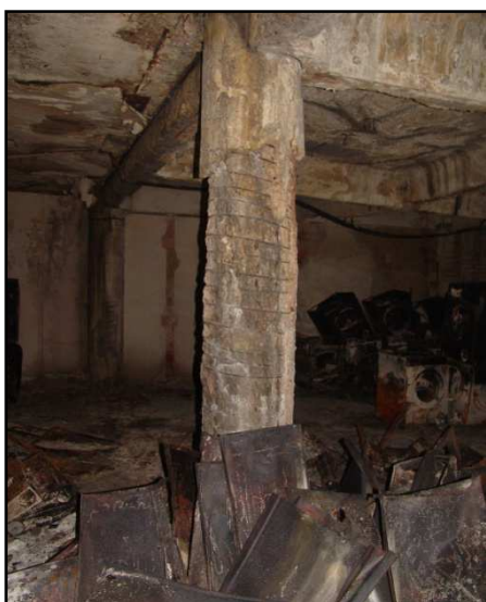
Obr. 2.6 Poškození ŽB sloupů SV části objektu C v 1. NP
