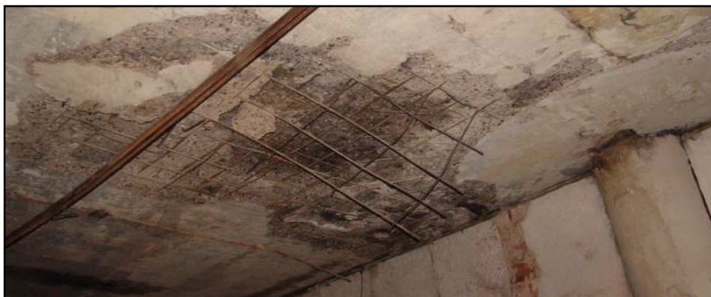
Obr. 1.2 Odštěpování krycích vrstev betonu z dolního líce stropní desky nad 1. NP části A
