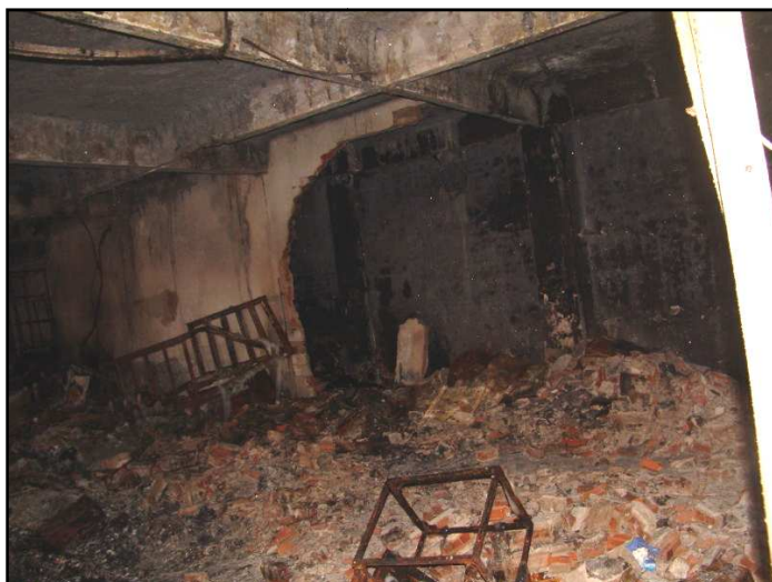
Obr. 2.8 Zřícená vestavěná dělící stěna v severovýchodní části objektu C 2. NP
