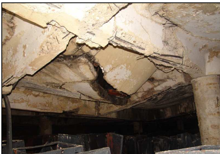
Obr. 2.3 Poškození stropní konstrukce severovýchodního křídla objektu C nad 1. NP
