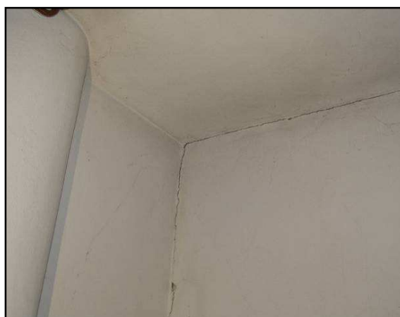
Obr. 1.9 Liniové trhliny v oblasti styků vestavěných dělicích konstrukcí a obvodového pláště na jižním průčelí v 1. PP
