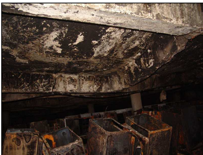
Obr. 2.1 Poškození stropní konstrukce severovýchodního křídla objektu C nad 1. NP
