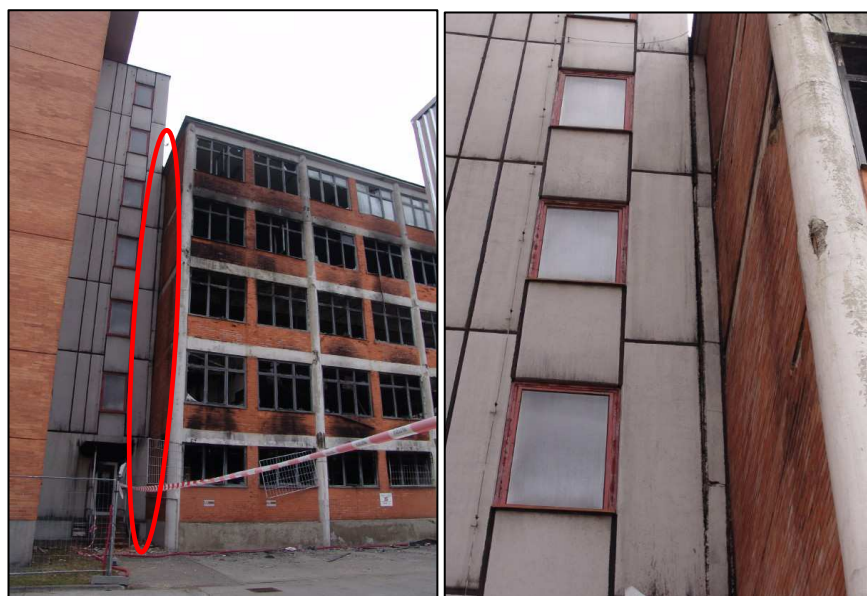
Obr. 1.12 Poškození prefabrikovaného obvodového pláště – východní průčelí, pohled z exteriéru
