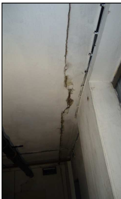
Obr. 1.14 Rozevření dilatační spáry u východní ztužující věže – dolní líc stropní konstrukce nad 1. PP
