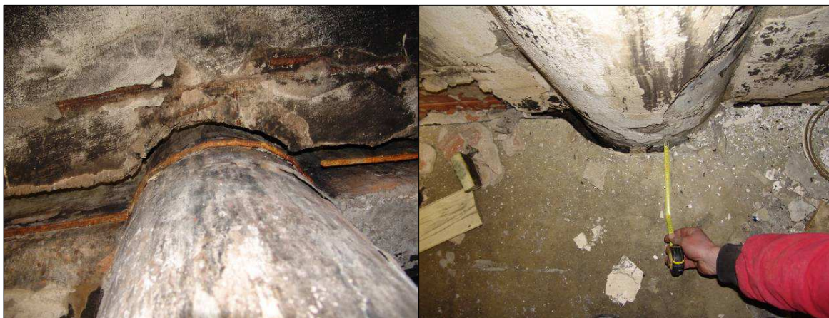
Obr. 1.16 Rozevření dilatační spáry mez stropními konstrukcemi části objektu C a A, pohled na dolní líc stropní konstrukce nad 1. NP
