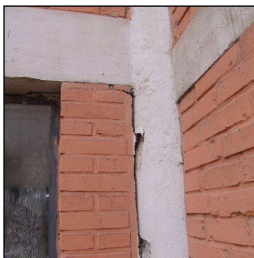
Obr. 2.11 Vybočení obvodového zdiva schodišťového tělesa objektu C
