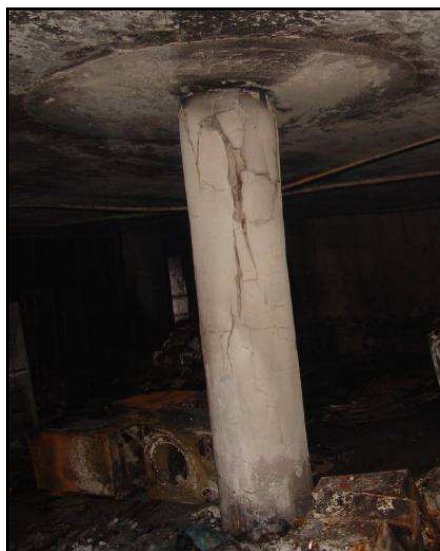
Obr 1.6 – Poškozené obezdívky ocelových sloupů v 1. NP
