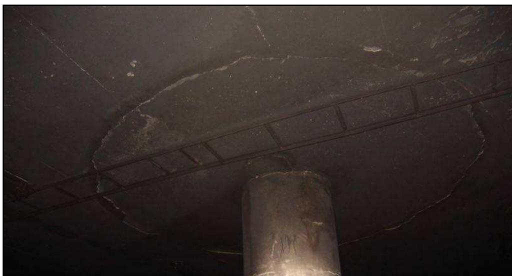
Obr. 1.4 Výrazné liniové trhliny (šířky 0,5 až 2,0 mm) a trhlina v oblasti styku předepnuté hlavice s navazující stropní konstrukcí, pohled z dolního líce stropní desky nad 1. NP
