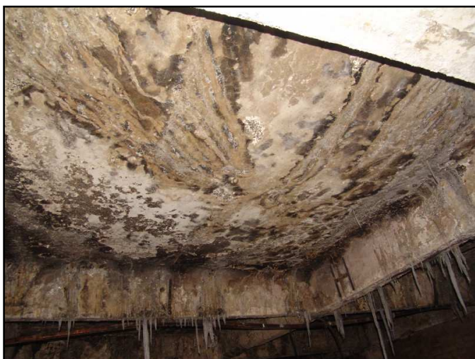
Obr. 2.5 Poškození stropní konstrukce severovýchodního křídla objektu C nad 3. NP
