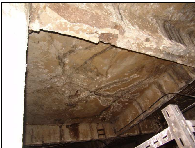
Obr. 2.4 Poškození stropní konstrukce severovýchodního křídla objektu C nad 2. NP
