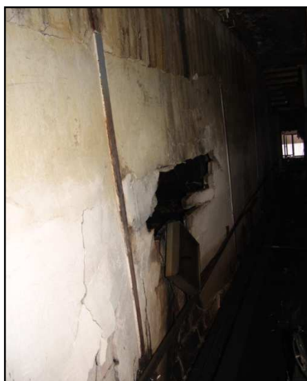
Obr. 2.7 Poškození dělicí stěny v chodbě 1. NP u kotelny
