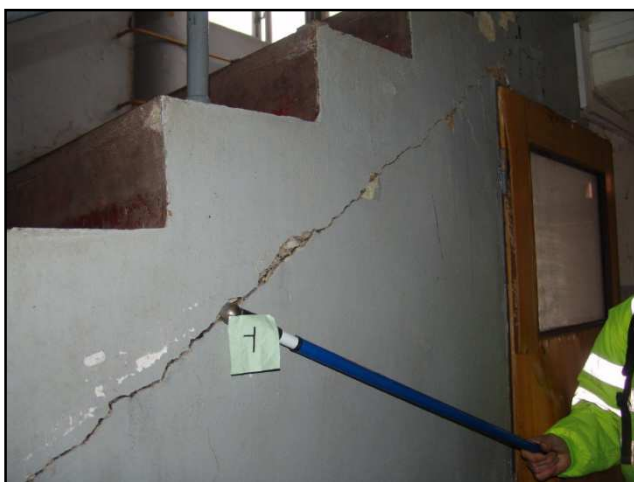
Obr. 2.14 Poškození schodišťového tělesa a přiléhající místnosti v 1. NP objektu C (detail odtržení vyzdívky od schodišťového ramene)
