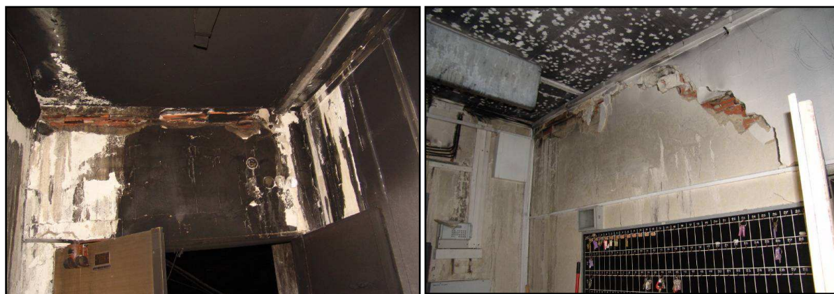
Obr. 1.17 Poruchy vestavěných dělicích stěn u východní věže v úrovni 1. NP
