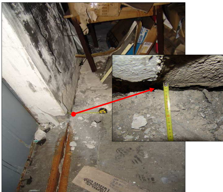
Obr. 1.15 Rozevření dilatační spáry u východní ztužující věže – podlaha v 2. NP
