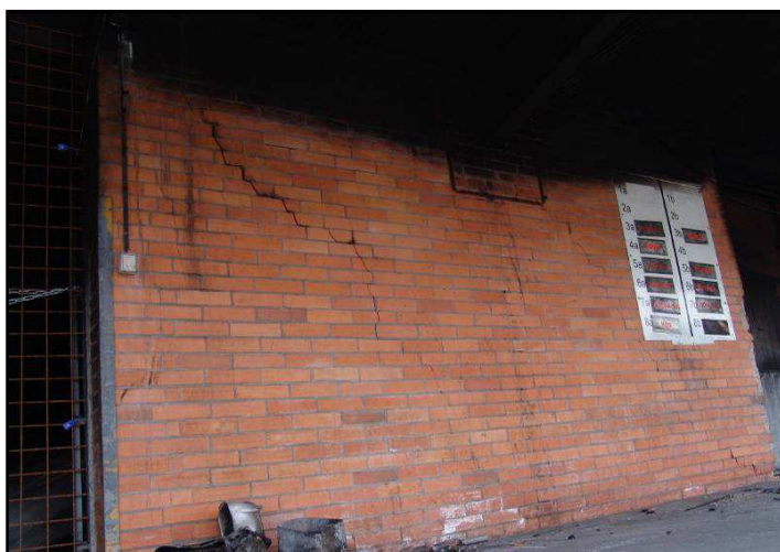
Obr. 1.11 Poruchy obvodové stěny ve východní části 1. NP objektu A – exteriér
