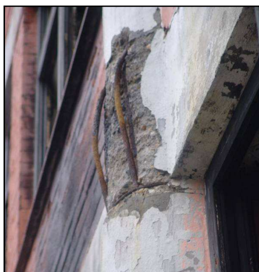
Obr. 2.10 Vybočení výztuže obvodových sloupů východního průčelí v úrovni stropu
