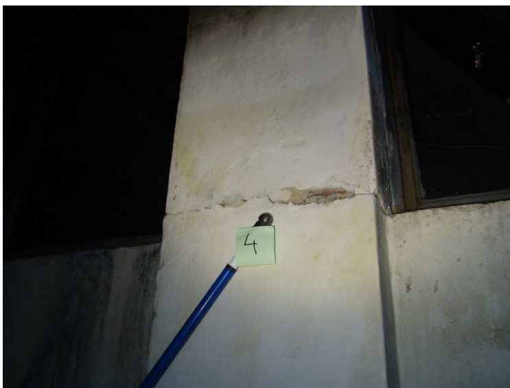
Obr. 2.19 Detail vybočení zhlaví nosného sloupu jednopodlažní přístavby kotelny
