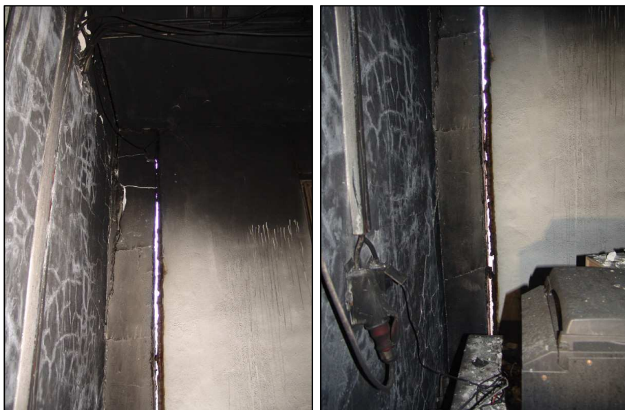
Obr 1.13 Poškození obvodového pláště – východní průčelí, pohled z interiéru
