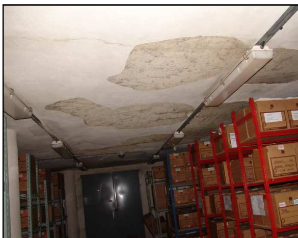
Obr. 1.8 Lokální odpadávání vrstev povrchových úprav dolního líce stropu nad 1. PP
