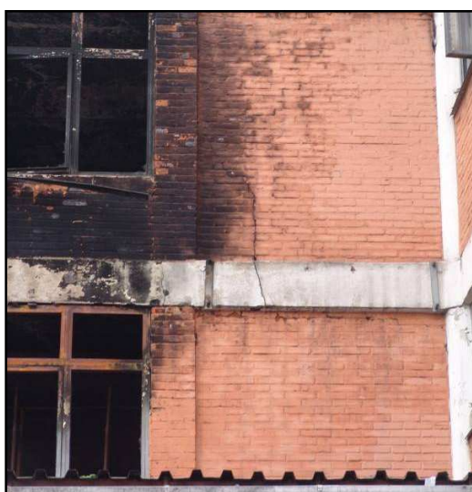
Obr. 2.9 Poškození obvodových nosných průvlaků severní obvodové stěny
