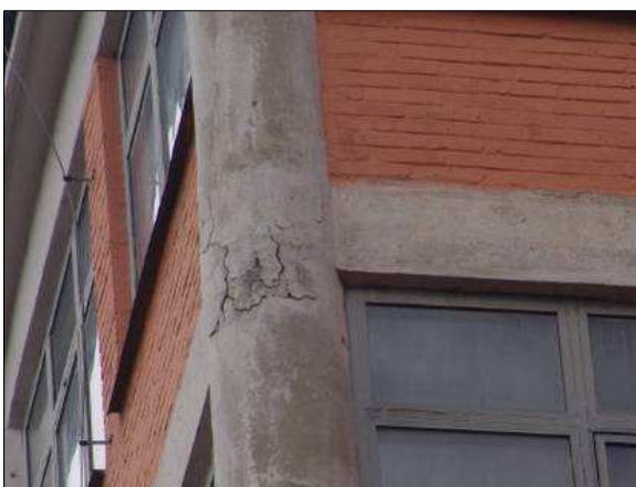
Obr. 2.16 Poškození obvodové stěny a obvodových sloupů západního průčelí
