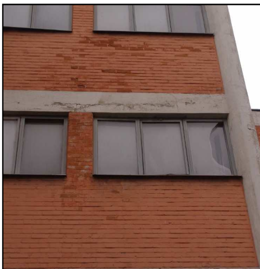
Obr. 2.12 Poškození obvodového průvlaku schodišťového tělesa objektu C
