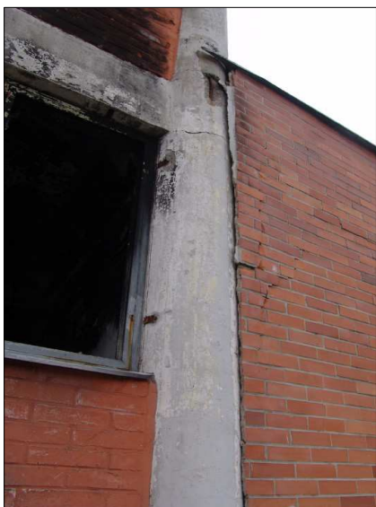
Obr. 2.18 Vytlačení obvodové stěny kotelny (část B)
