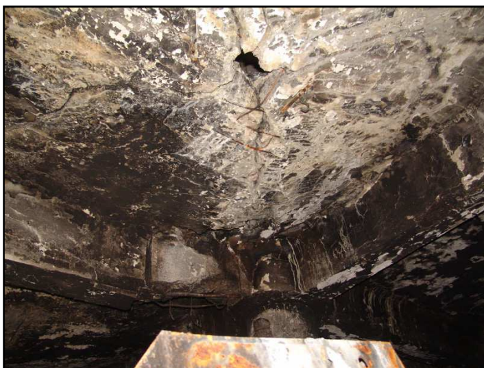
Obr. 2.2 Poškození stropní konstrukce severovýchodního křídla objektu C nad 1. NP
