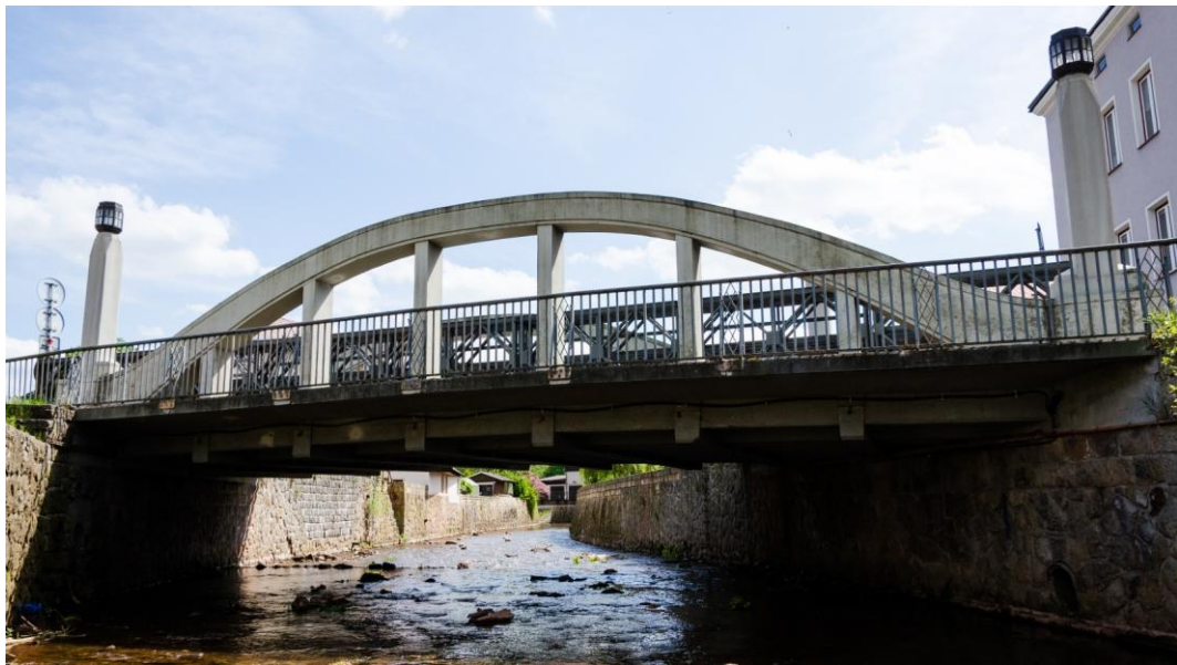
Obrázek 4.4 Pohled na mostní konstrukci z koryta říčky Čistá
