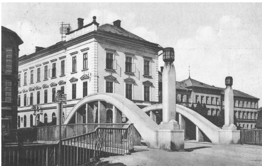
Obrázek 8.3 Dokončený most, na pozadí je základní škola a gymnázium
