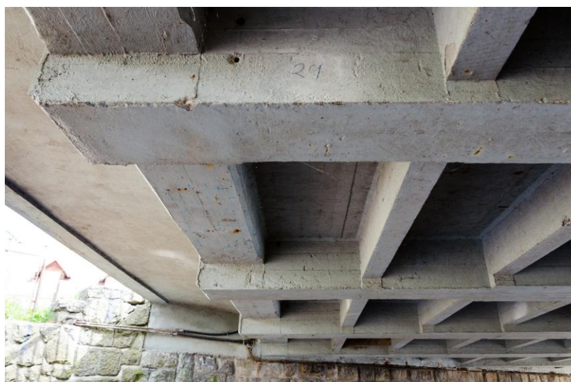
Obrázek 8.17 Pohled na trám (vlevo) a podélné výztuhy (vpravo)
