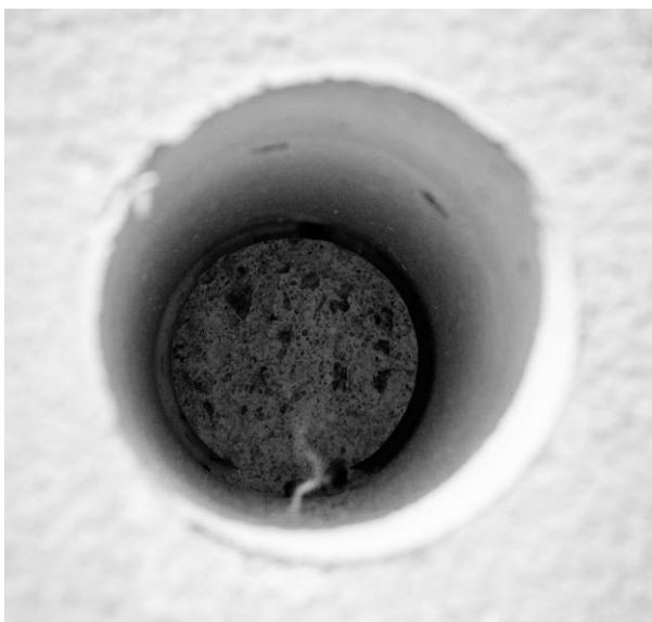
Obrázek 3.10 Pohled do otvoru po jádrovém vývrtnu průměru 50 mm
