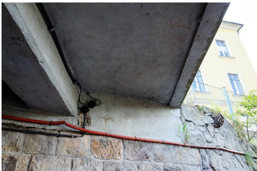
Obrázek 8.19 Okraj uložení mostu a cizími zařízení
