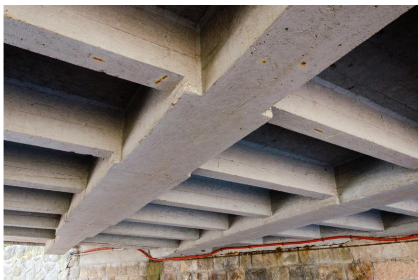
Obrázek 8.15 Profil příčnicku s proměnlivými rozměry
