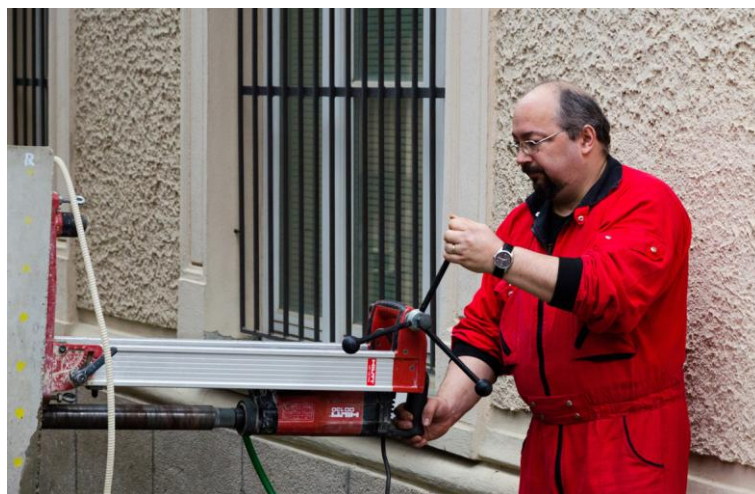
Obrázek 3.4 Provádění jádrového vývrty průměru 50 mm
