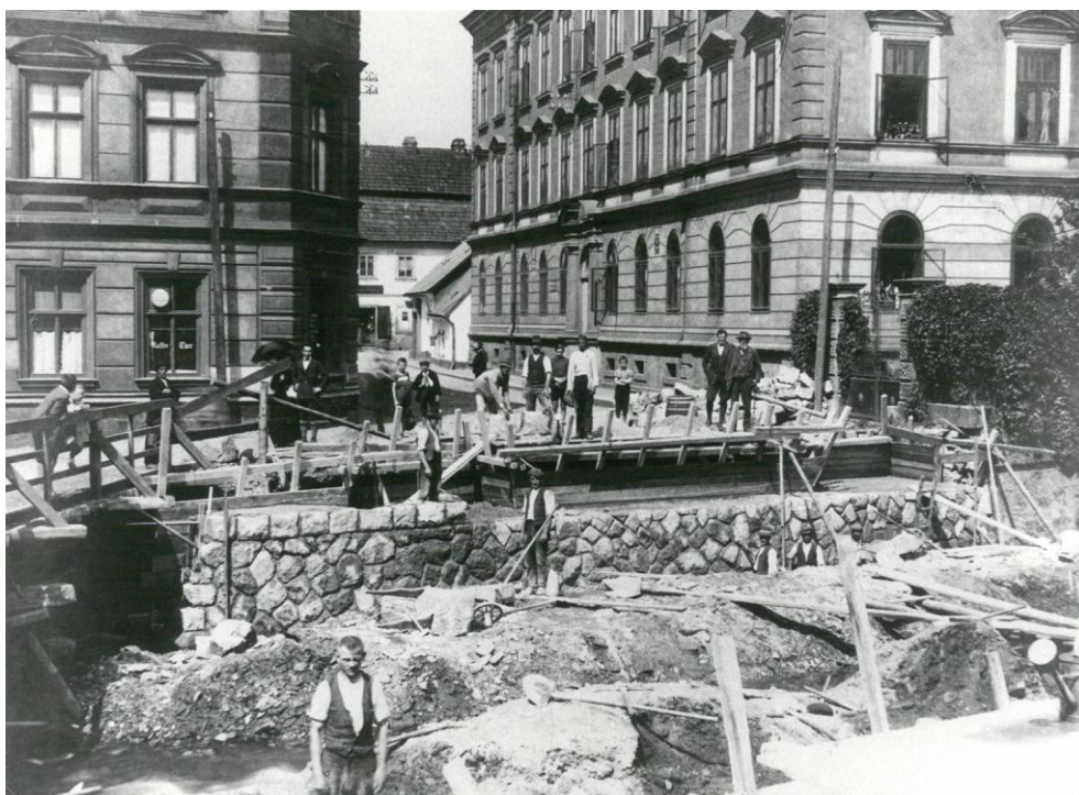
Obrázek 8.2 Výstavba opěr mostu přes Čistou v srpnu 1923
