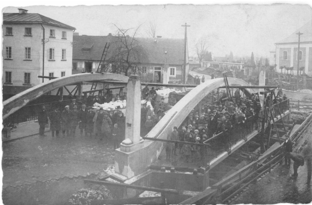
Obrázek 4.2 Zatěžkávací zkouška nového mostu 29. listopadu 1923 [20]
