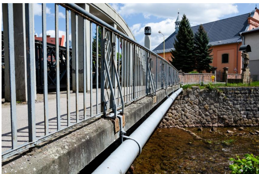
Obrázek 8.21 Vybavení mostu: zábradlí; Cizí zařízení: vodohospodářská trubka
