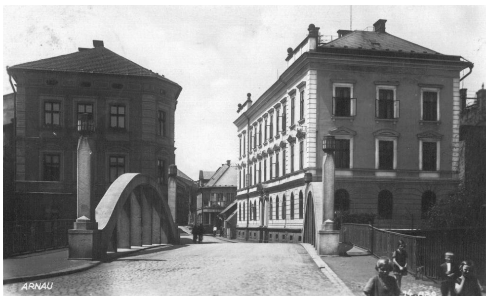
Obrázek 8.4 Dokončený most při pohledu směrem k náměstí
