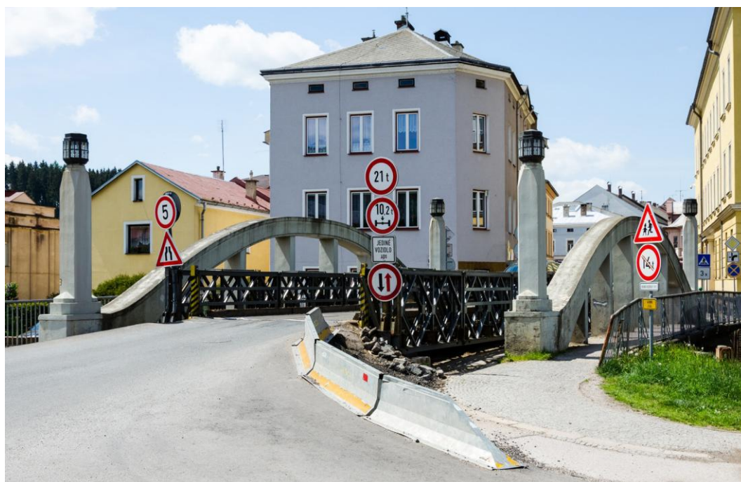
Obrázek 4.3 Současný stav mostu s mostním provizoriem (foceno 17. 5. 2015)
