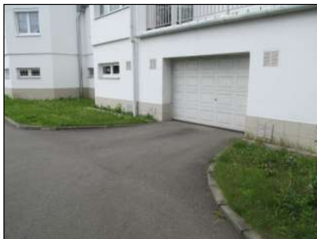
Foto č. 9: Vjezd do garáže v suterénu
