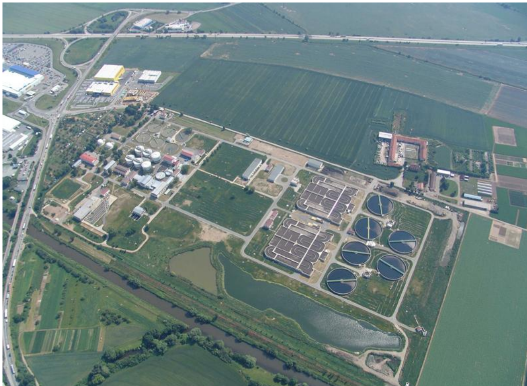
Obr. 24 Čistírna odpadních vod Modřice [70]
