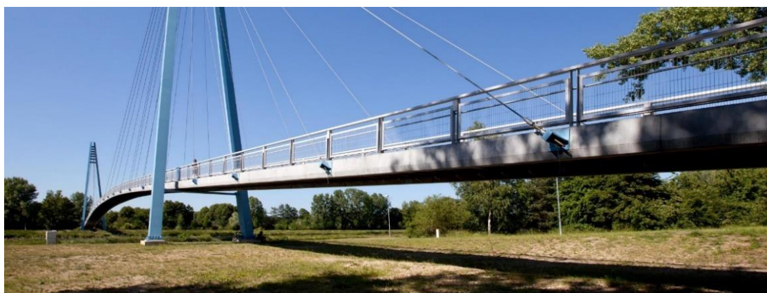
Obr. 12: Lávka v Čelákovících přes řeku Labe [58]
