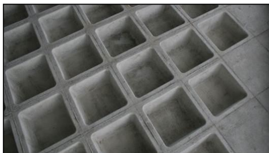
Obrázek 7 - Vylehčení ve skladbě konstrukce [30]
